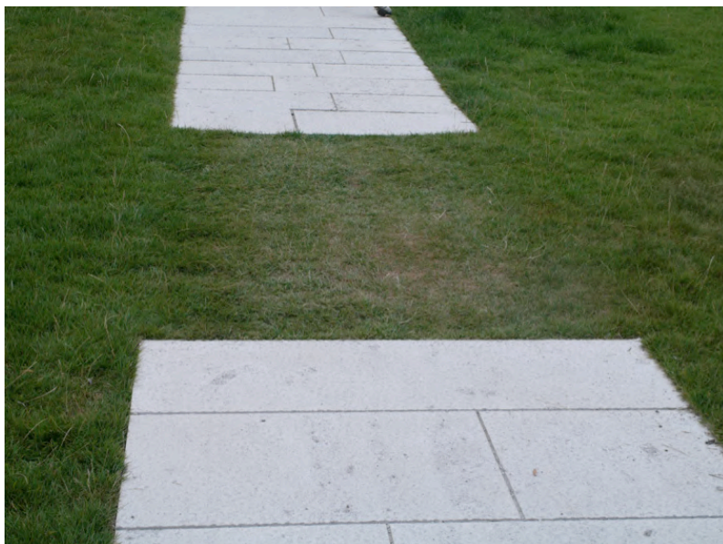
Fig. 1. Percorso esterno intorno alla basilica di Aquileia: per un breve tratto, la pavimentazione continua che consente di attraversare il prato in maniera agevole anche con mezzi su ruote è volutamente interrotta.
