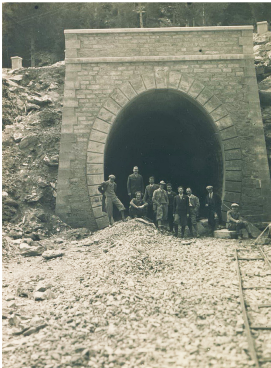
Sopralluogo degli allievi della Scuola di applicazione per Ingegneri di Torino al cantiere del traforo, ASPoliTo, Archivio Storico del Politecnico di Torino
