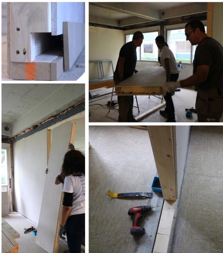
*Fig. 59 – Sistema di partizione interna con sottostruttura in legno e finitura in cartongesso, con zoccolo removibile per passaggio impiantistico (© VUB Architectural Engineering | Photo: KADERSTUDIO)*
