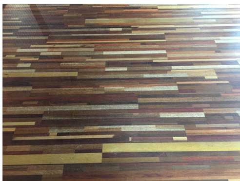
Fig. 37 – Recupero di travi di abete rosso e pino per la produzione della pavimentazione
