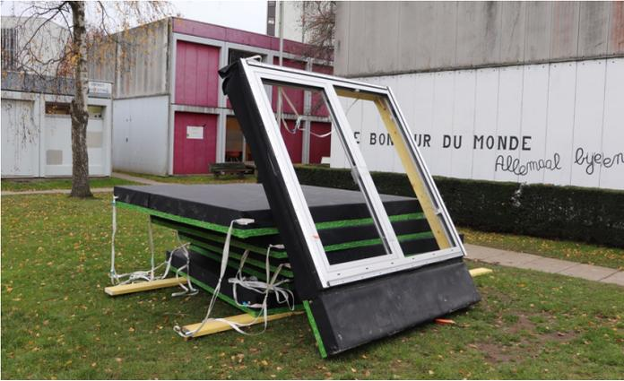
*Fig. 53 – Pannello modulare e prefabbricato, contenente l'elemento finestra, e installato a secco sulla struttura portante esistente (© VUB Architectural Engineering | Photo: KADERSTUDIO)*
