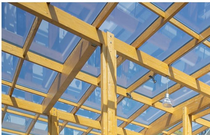
*Fig. 64 – Dettaglio della struttura portante disassemblabile, in legno lamellare nel nodo tra pilastro e trave (credit Petra Appelhof and RAU)*
