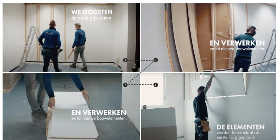
Fig. 36 – Processo operativo per il recupero e riuso delle lastre in cartongesso (fonte: *Urban Mining Collective*, <https://newhorizon.nl/material-balance/productoverzicht/productdetail?id=3066>)
