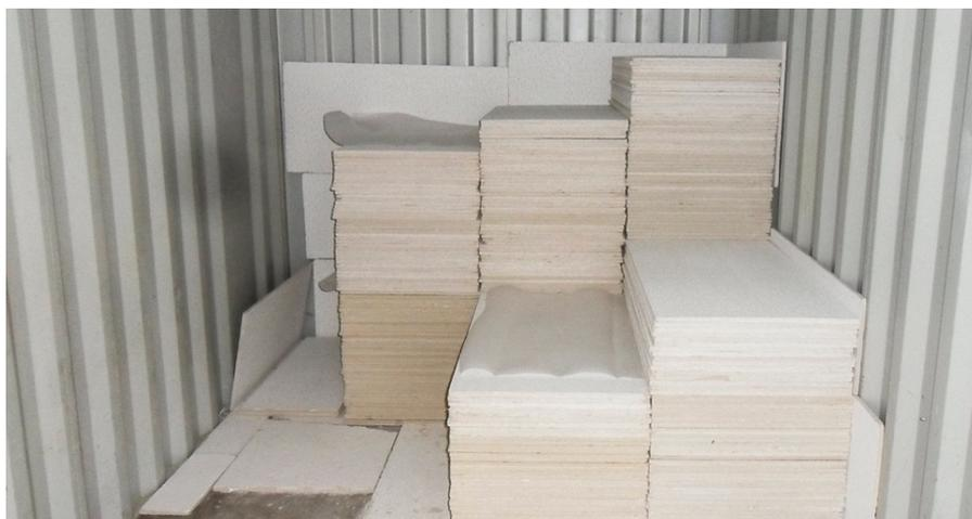
*Fig. 44 – Stoccaggio per il riuso di componenti in uscita (controsoffitti) dal processo di demolizione di alcune parti della sede di Alliander Headquarter (credits Ben Vulkers, Thomas Heye and Marcel van der Burg, and RAU)*
