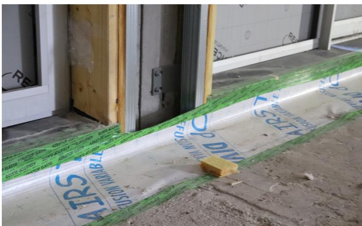
*Fig. 56 – Nastratura interna di tenuta all'aria dei moduli di facciata (© VUB Architectural Engineering | Photo: KADERSTUDIO)*
