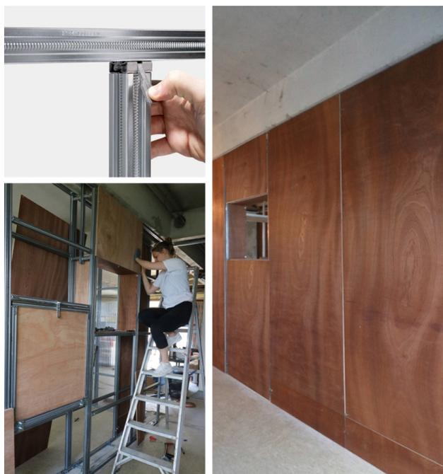
*Fig. 58 – Sistema di partizione interna con sottostruttura metallica con giunti reversibili, e finitura in tavolati di legno (© VUB Architectural Engineering | Photo: KADERSTUDIO)*
