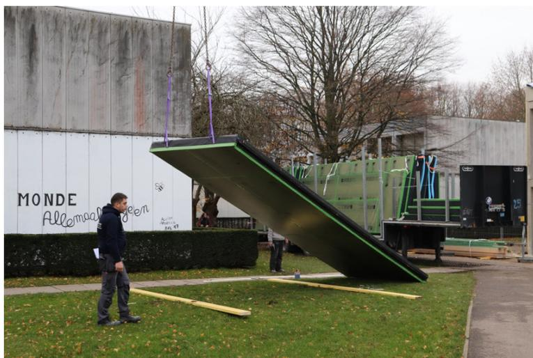
Fig. 52 – Pannello di facciata modulare e prefabbricato, installato a secco sulla struttura portante esistente (© VUB Architectural Engineering | Photo: KADERSTUDIO)
