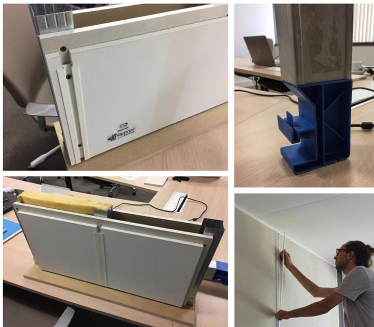
*Fig. 60 – Sistema di partizione interna con sottostruttura metallica con giunto di connessione tra montante e pannello accessibile e rivestito con profilo ad omega reversibile (© VUB Architectural Engineering | Photo: KADERSTUDIO)*
