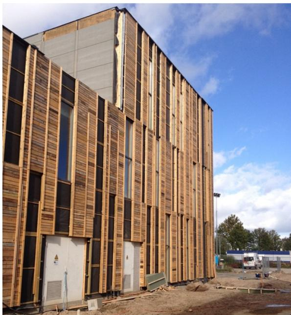
*Fig. 48 – Fase di costruzione del sistema di facciata a secco, con rivestimento in legno di riuso, applicata alla chiusura verticale esistente esposta verso l'interno del nuovo complesso edilizio (credits Ben Vulkers, Thomas Heye and Marcel van der Burg, and RAU)*
