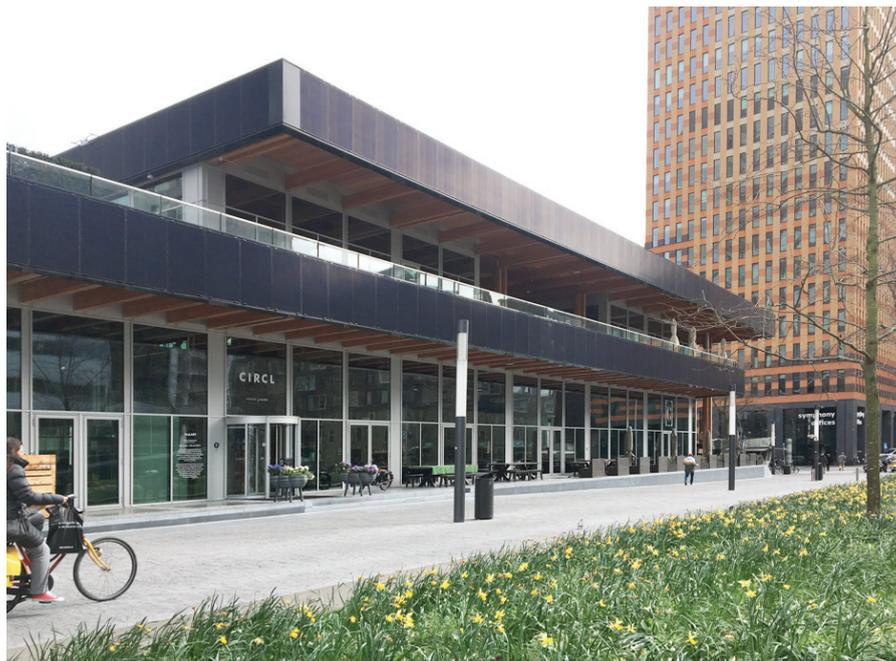
*Fig. 68 – Circl Pavilion, edificio di nuova costruzione, pensato per essere completamente smontato a fine vita e riutilizzato nei suoi elementi*
