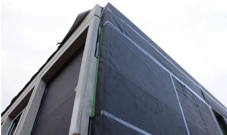
*Fig. 55 – Membrana di tenuta all'aria di rivestimento ai pannelli modulari a secco (© VUB Architectural Engineering | Photo: KADERSTUDIO)*
