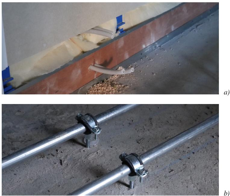
Fig. 57 a – Sistema impiantistico posizionato dietro allo zoccolo removibile delle pareti verticali; b – Sistema impiantistico posizionato a secco sotto il pavimento flottante (© VUB Architectural Engineering | Photo: KADERSTUDIO)
