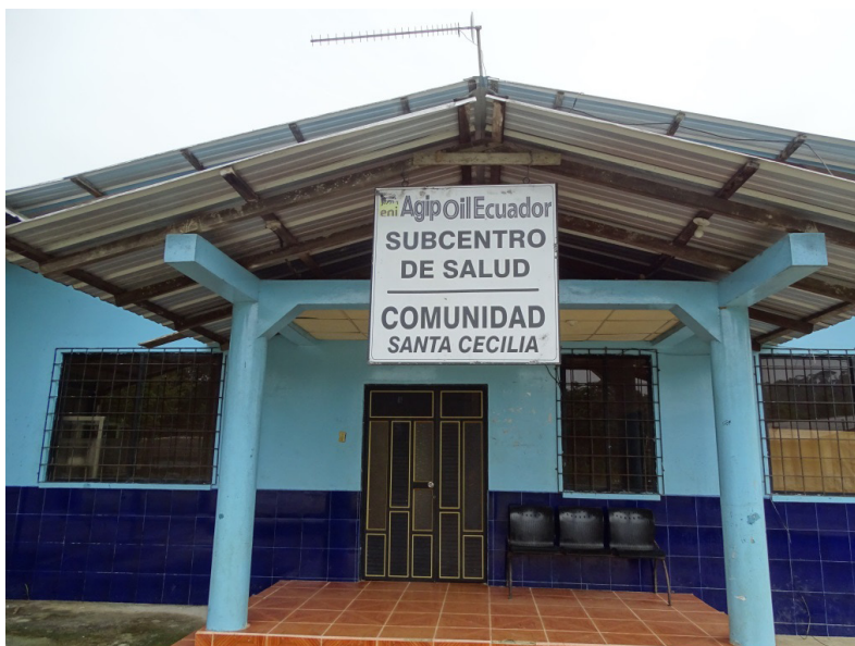
Fig. 1 - Un centro medico realizzato da Agip in una comunita. Fonte: foto dell'autore
