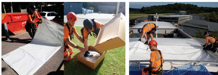
Fig. 2 - Caso 1B. Disassemblaggio e riassetaggio del tetto della sede Vodafone in cuscini pneumatici (foto: Vector Foiltec)
