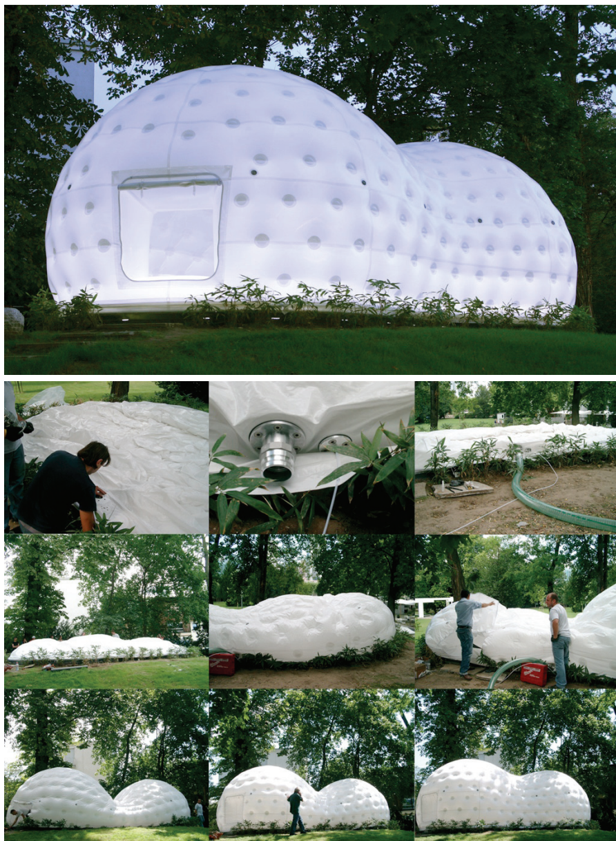
Fig. 3 - Caso 2. Padiglione itinerante gonfiabile in tessuto tenara di e-ptfe rivestito di ptfe, la cui durabilità è garantita per 30 anni. La longevità della membrana e la forma architettonica definita da Kengo Kuma suggeriscono un atteggiamento di riutilizzo nel tempo, piuttosto che la sua rimanifattura, marcando un limite al DfRem (foto: studio form-TL)
