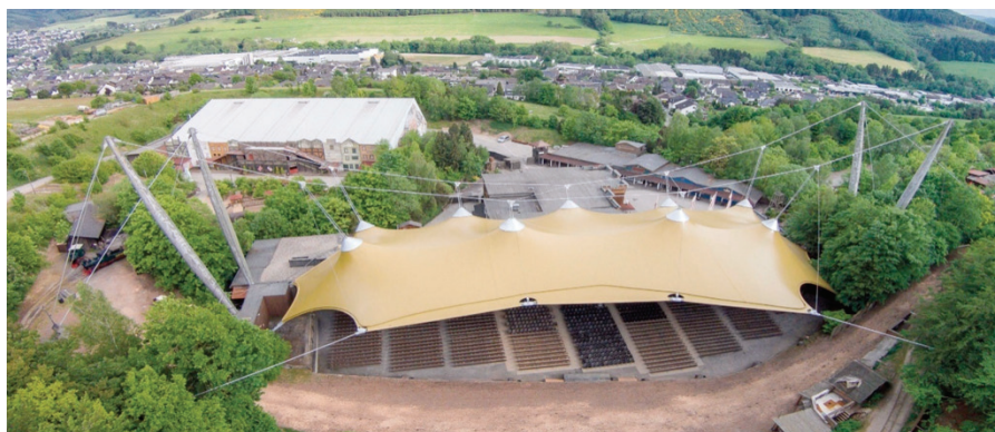
Fig. 1 - Caso 1A. Tensostruttura a membrana tessile per il grandstand di Elsie, in tessile tecnico di pes/pvc/pvdf (foto: Mehler technology)
