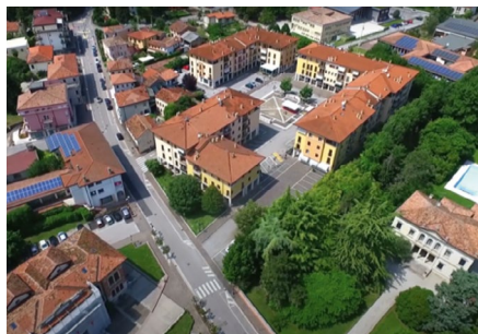
Fig. 1 - Installazione di pannelli fotovoltaici nel centro urbano di Ponte di Piave (TV). Fonte: www.google.com/intl/it/earth .
