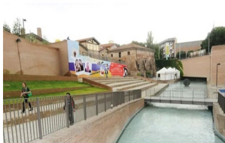
a. Centrale idroelettrica del Cavaticcio, Bologna.
