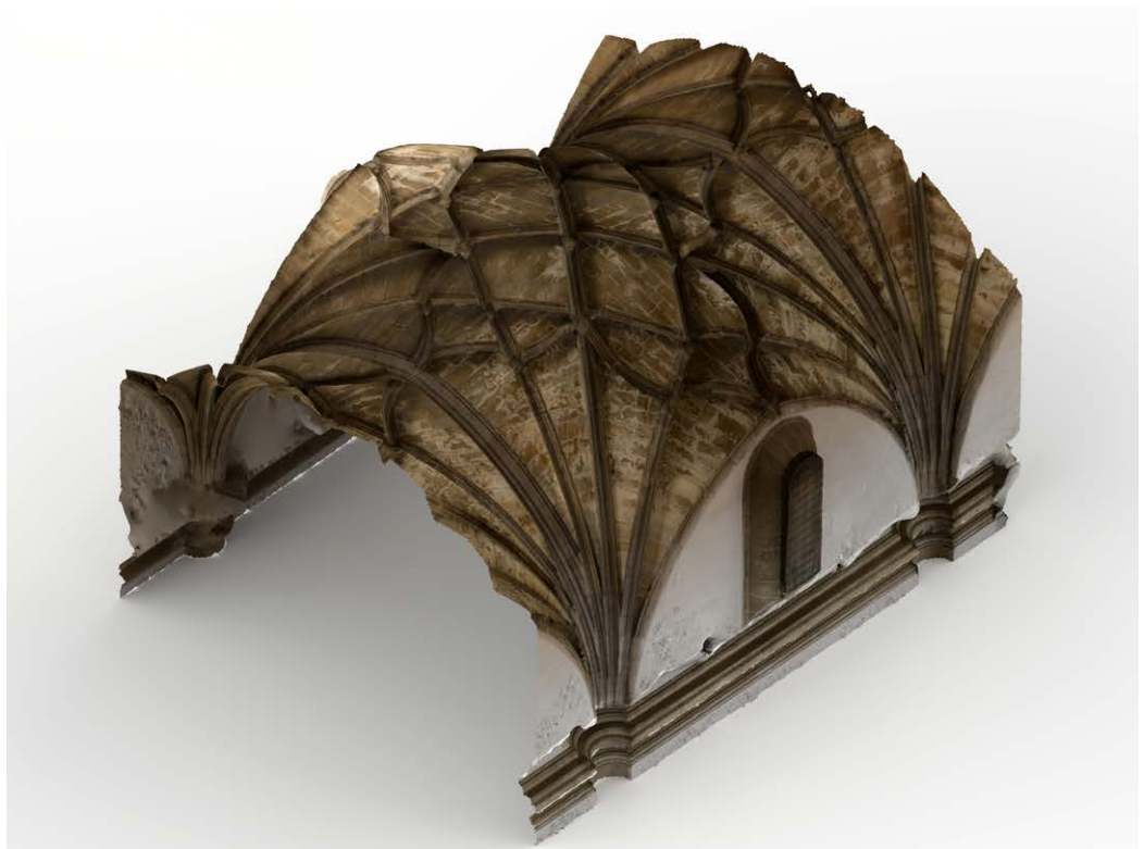
Fig. 8. Vista prospettica dal basso e assonometrica della mesh poligonale della campata centrale ottenuta attraverso il rilievo fotogrammetrico (elaborazione grafica A. Bortot).
