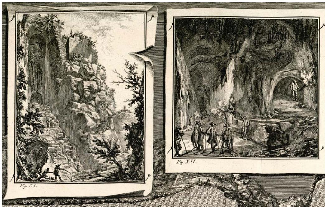
Fig. 3. Veduta interna dello speco dell'emissario nell'incontro con il cunicolo inclinato, ingrandimento da Dimostrazioni dell'Emissario del Lago Fucino (G. B. Piranesi, F. Piranesi, 1791).
