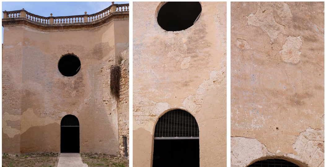
Fig. 4. Marsala. Complesso di Santa Maria della Grotta, tracce del portale inciso nella facciata della chiesa. Foto di M. Cannella.
