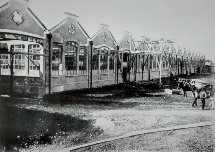
Fig. 3 Torino. Ex Stabilimento Itala in costruzione. Fotografia di inizio '900. Turin. Former Itala factory under construction. Early 20 th century photography. (© ASF Archivio Storico Fiat)
