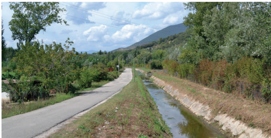
Fig. 8 - San Salvatore Telesino, sezione stradale [Foto di E. Manzo].
