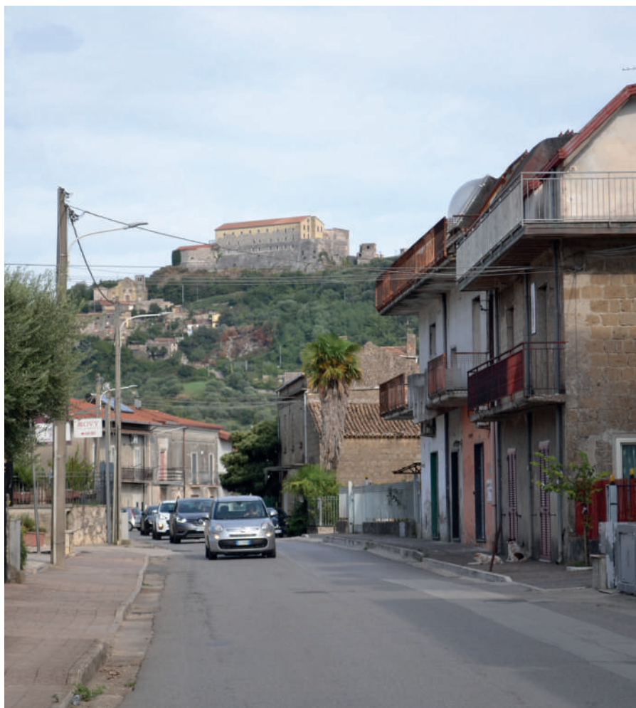
Fig. 4 - Montesarchio, vista dell'abitato con il centro storico sullo sfondo [Foto di E. Manzo].
