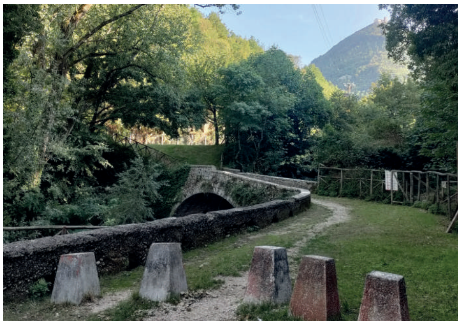
Fig. 19 - Montella, ponte sulla cascata del Fascio con vista sul fondo del santuario del Santissimo Salvatore [Foto di F. Fiorillo].
