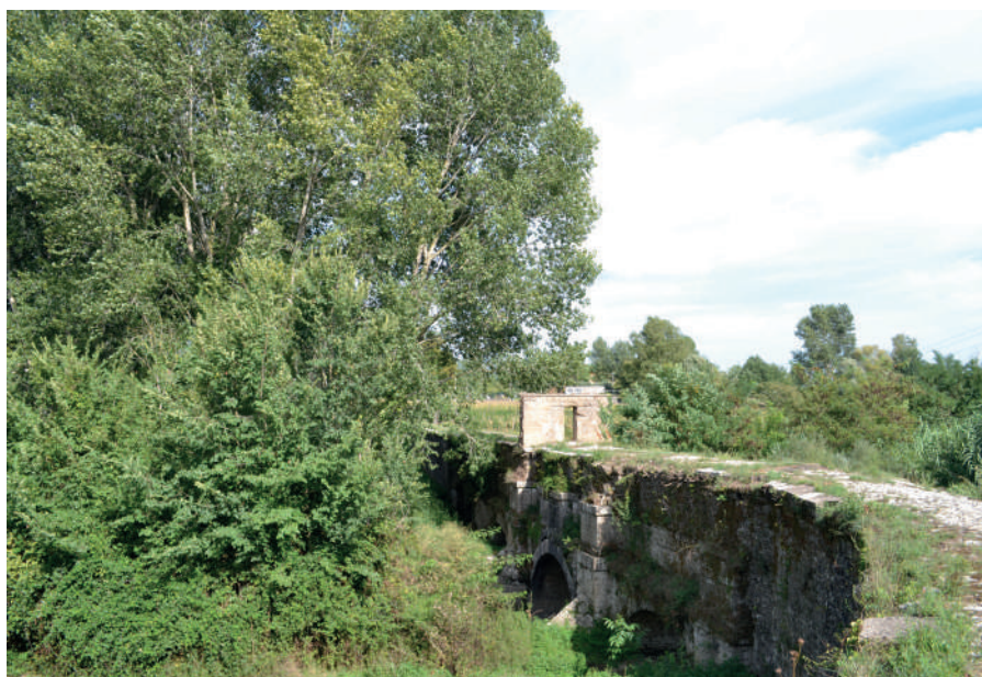
Fig. 6 - Moiano, percorso ciclopedonale "La via dell'acqua disegnata dall'Acquedotto Carolino" [Foto di E. Manzo].
