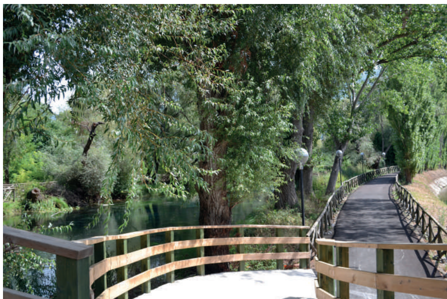
Fig. 1 - San Salvatore Telesino, viabilità ciclopedonale [Foto di E. Manzo].
