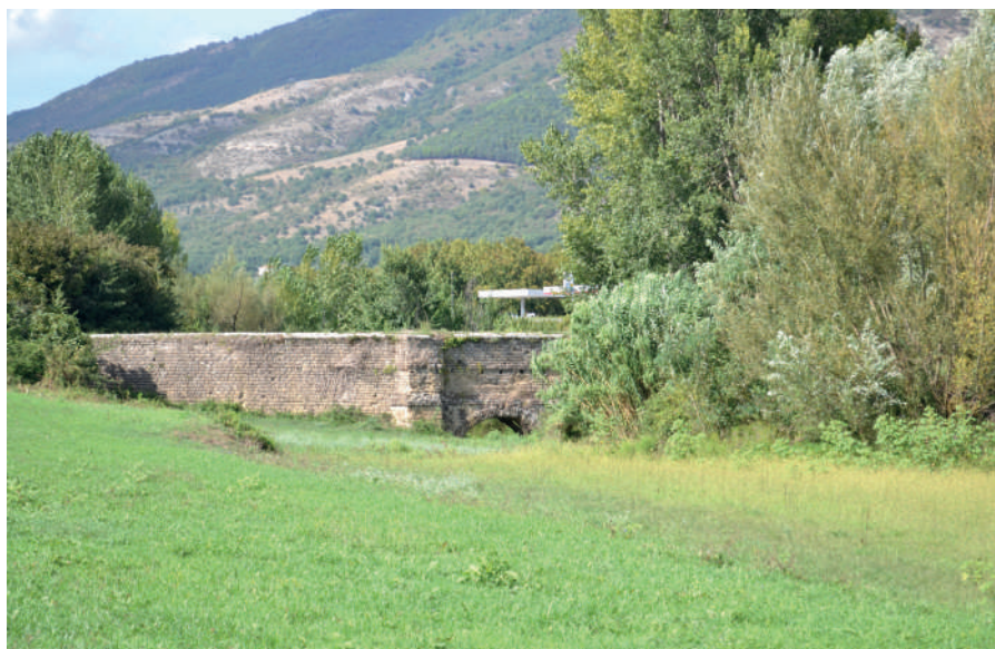
Fig. 8 - Moiano, Ponte Carlo III [Foto di E. Manzo].
