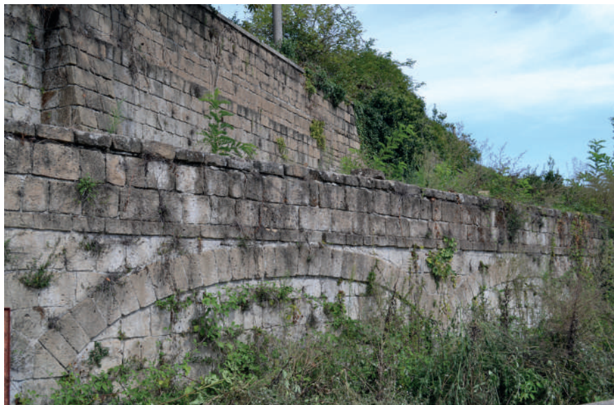
Fig. 6 - Moiano, Ponte Carlo III con particolare della struttura realizzata da Luigi Vanvitelli [Foto di E. Manzo].
