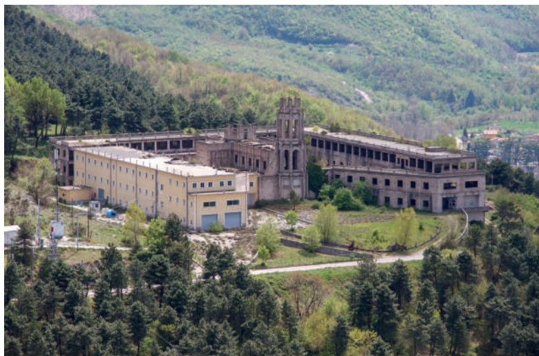
Montesano sulla Marcellana, convento incompiuto dello "Scialandro" [Foto di W.A. Lamattina].
