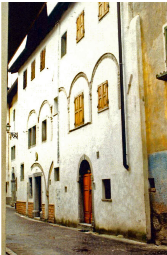
Il tipo della casa carnica nel Comune di Paularo. Caso emblematico di modifica della facciata con relativa tamponatura delle aperture ad arco che risultano comunque chiaramente visibili nel prospetto
