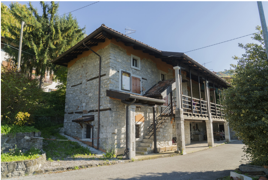
Esempio di casa a ballatoio con avancorpo nella località di Scubina (Roda Alta) nel Comune di Pulfero (UD). Foto dopo i recenti interventi di recupero per riportare a vista la tessitura muraria originaria
