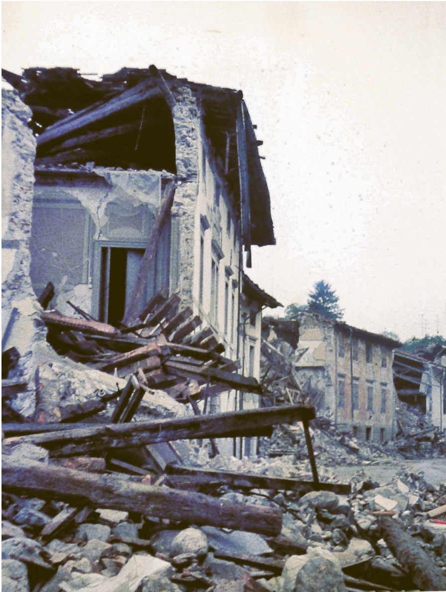
Fig. 5 - I danni causati dal terremoto del 1976 a Gemona del Friuli (UD)
