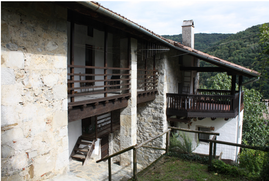
Fig. 42 - Edificio situato nelle Valli del Natisone, oggetto di un recupero art. 8 della Legge 30/77. Rimangono invariati i caratteri costitutivi di tale tipo a ballatoio ligneo su pilastro in pietra con corpo aggettante
