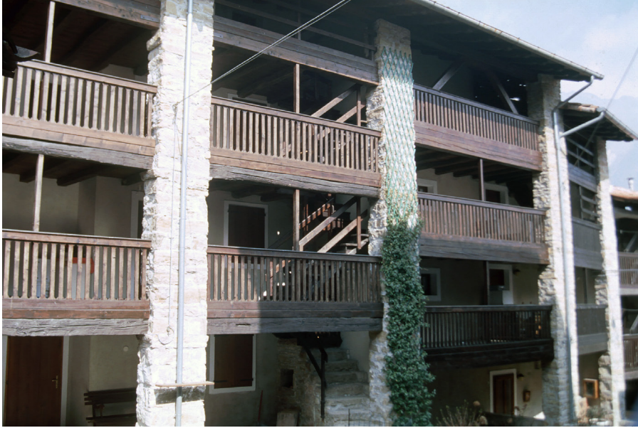
Esempio di tipo di casa a ballatoi su pilastri in pietra nella località di Frisanco (PN) nella Val Colvera. Si evidenzia il dettaglio della prima scala di accesso ai piani superiori in pietra
