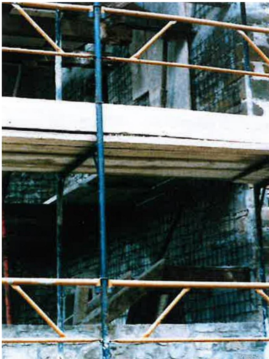
Fig. 30 - Esempio di intervento con rete e betoncino su murature di un poggiolo, nel borgo di Menis in località Frisanco (PN)
