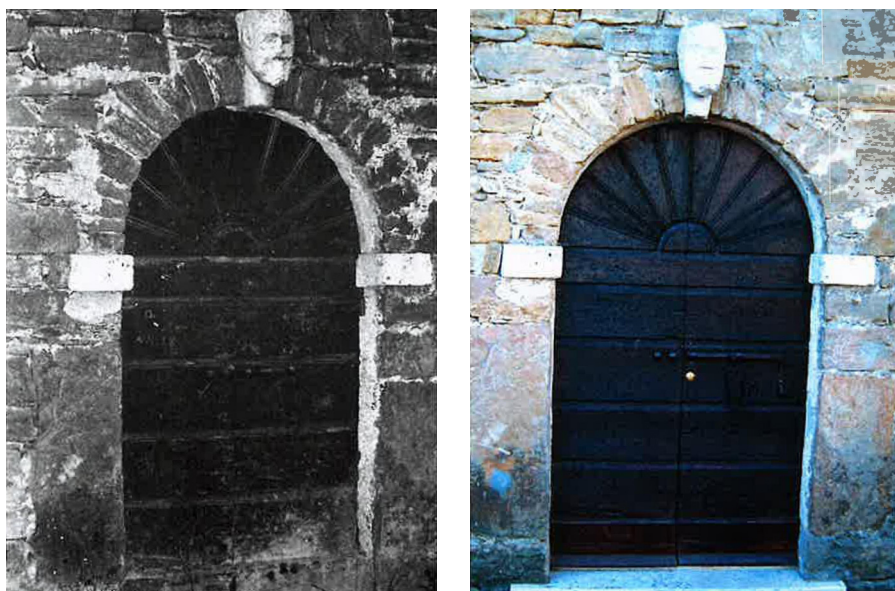
Fig. 29 - Esempio di recupero di un architrave del portone di ingresso di una abitazione. Foto prima e dopo l'intervento di consolidamento con il mantenimento dei caratteri architettonici originali
