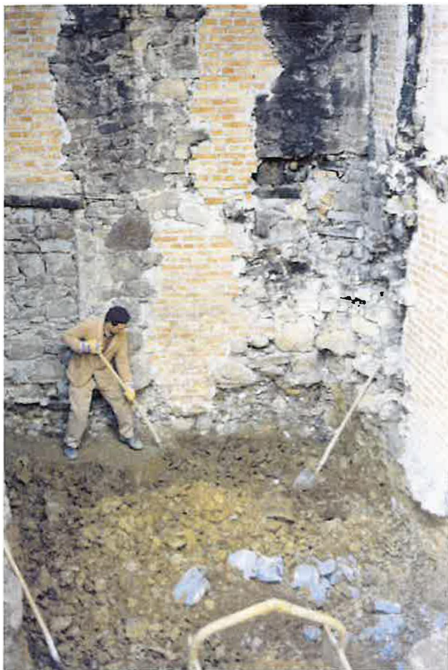
Fig. 31 - Messa in sicurezza di muratura interna di mattoni pieni, lesionata e ripristinata con il metodo dello cuci-scuci e che verrà poi successivamente rivestita e rinforzata con la rete armata
