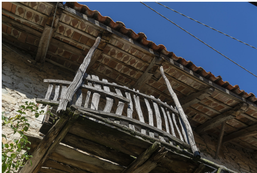
Fig. 9 - Particolare di una sporgenza della copertura sopra un ballatoio sorretto da montanti lignei di un edificio (situato nella località di Calla-Valli del Natisone) nel quale non sono stati effettuati interventi di recupero. Si nota la finitura delle tavelle in laterizio nell'intradosso che modulano una ritmicità diagonale della cromia. Tale cromia era stata ottenuta immergendole parzialmente nel latte di calce
