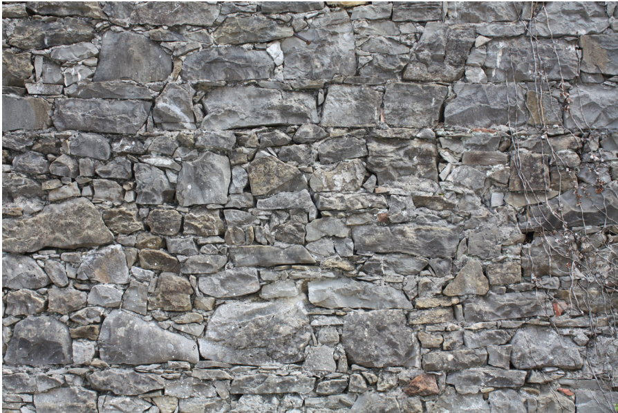
Fig. 2 - Esempio di paramento murario di un edificio vernacolare delle Valli del Natisone. Rappresenta chiaramente la qualità e il dettaglio delle lavorazioni della pietra locale che venivano attuate per le finiture esterne degli edifici, prima degli interventi post-sisma
