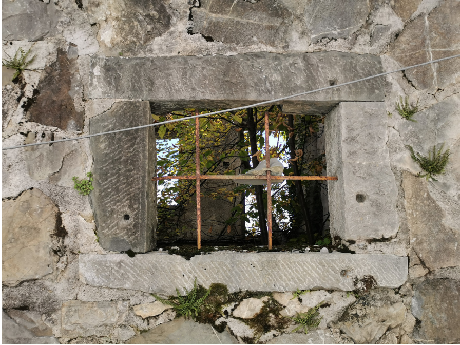
Fig. 12 - Dettaglio di una finestra al piano terreno protetta da inferriata a maglia quadra in ferro tondo con incroci ad anello fissati nei masselli in pietra
