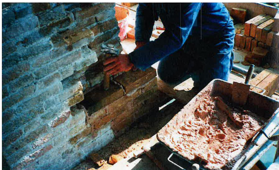
Fig. 25 - Ricostruzione della parete con l'inserimento di nuovi mattoni con l'aggiunta di cocciopesto alla malta
