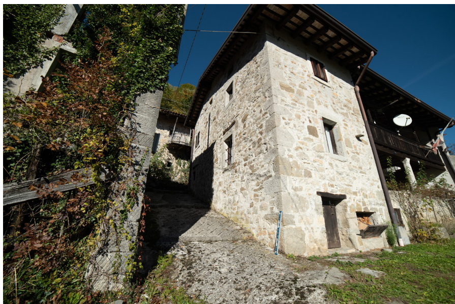
Particolare della tessitura muraria dell'avancorpo dell'edificio di Calla Superiore
