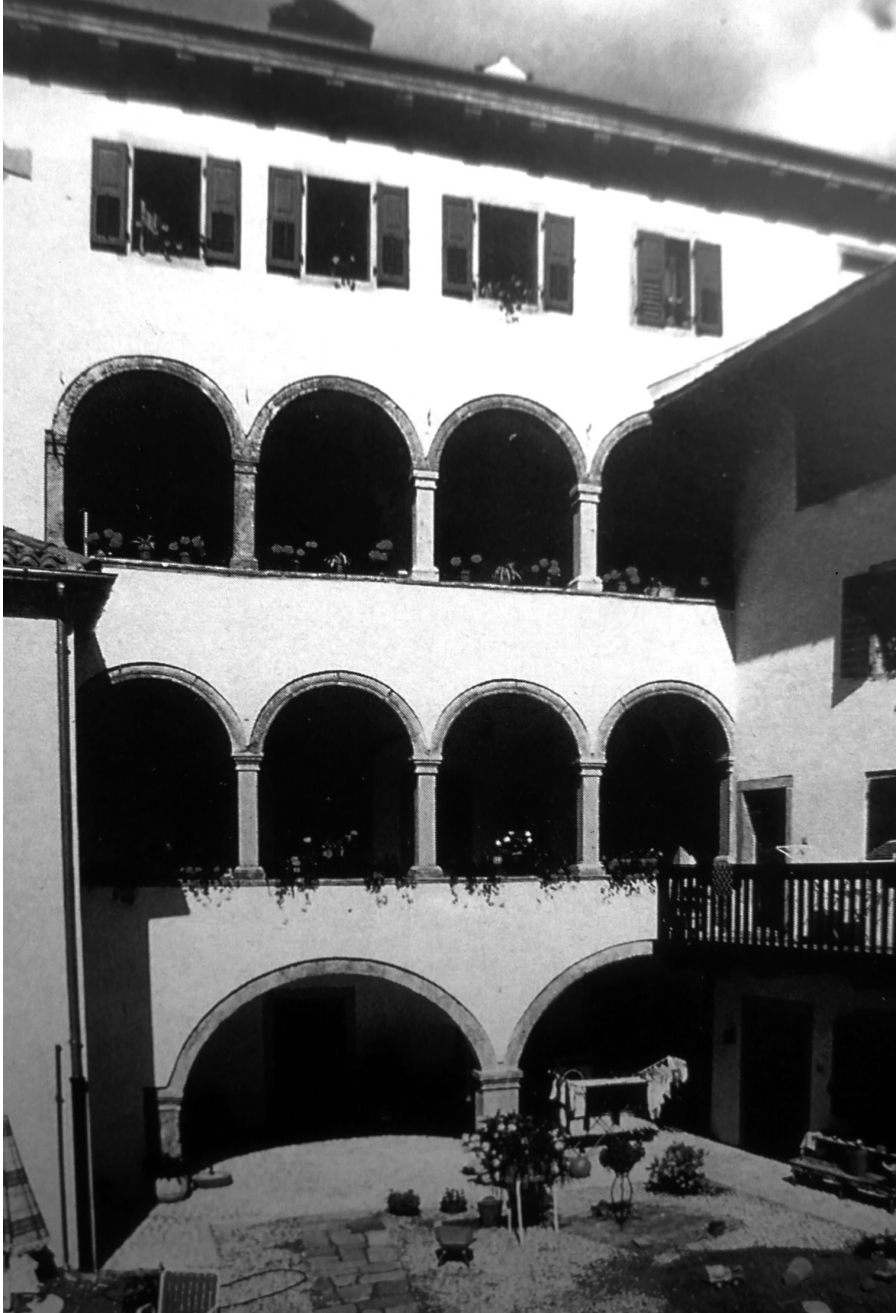
Esempio di casa carnica ad archi sviluppata su più piani con gli spazi distributivi longitudinali alla facciata e posteriormente alle arcate
