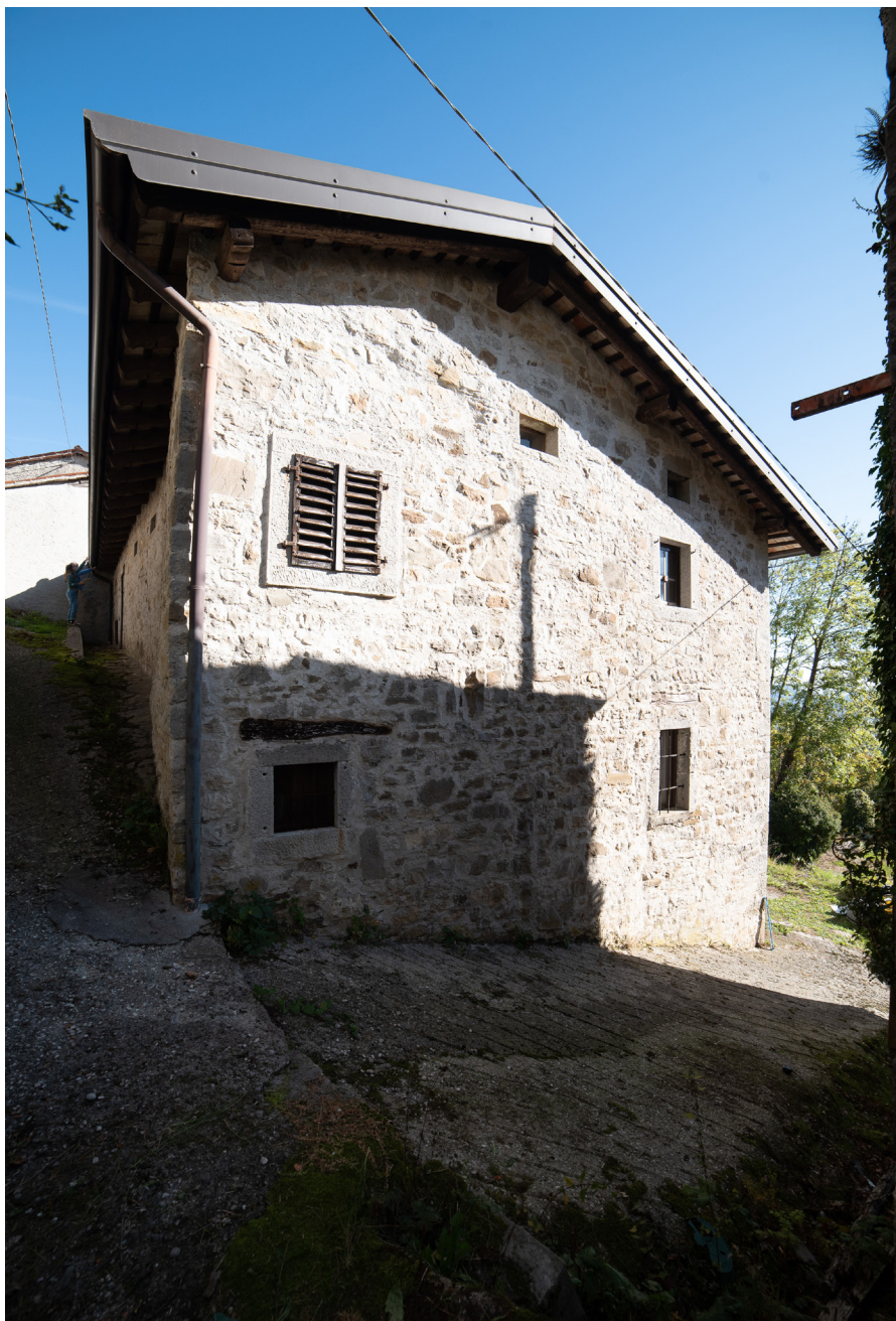
Il prospetto ovest dell'edificio di Calla Superiore. Il prospetto oltre alla caratteristica tessitura murari evidenzia la tipica costruzione che segue l'andamento delle curve di livello del terreno
