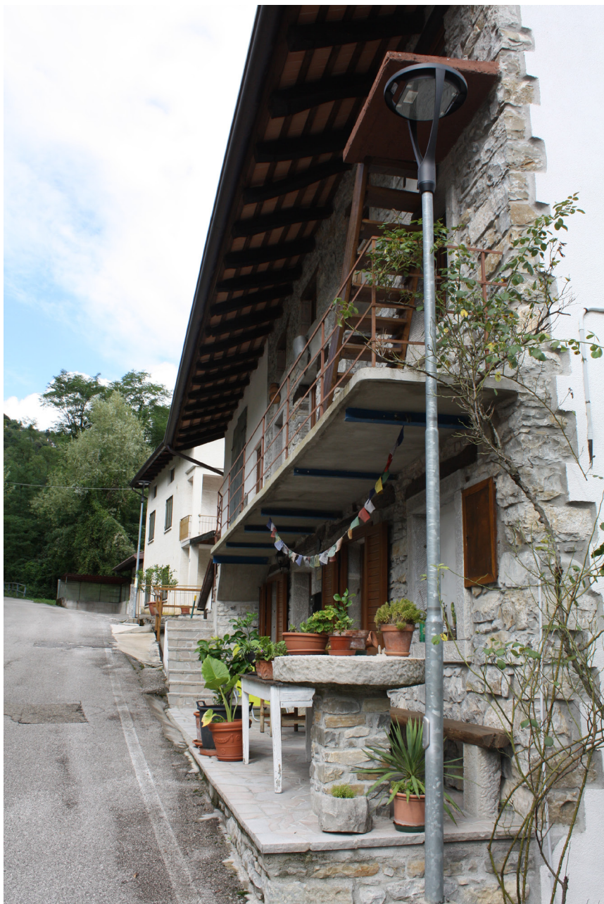
Fig. 43 - Edificio situato nelle Valli del Natisone, oggetto di un recupero post-sima del 1976. La sostituzione del tipico ballatoio ligneo, con una soletta in calcestruzzo armato su profili metallici a sbalzo, denota la perdita di un elemento originario caratterizzante l'architettura spontanea delle Valli
