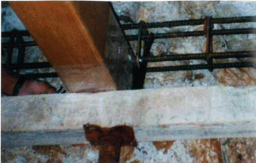
Fig. 34 - Realizzazione di cordolo armato in calcestruzzo armato per la realizzazione di un nuovo solaio
