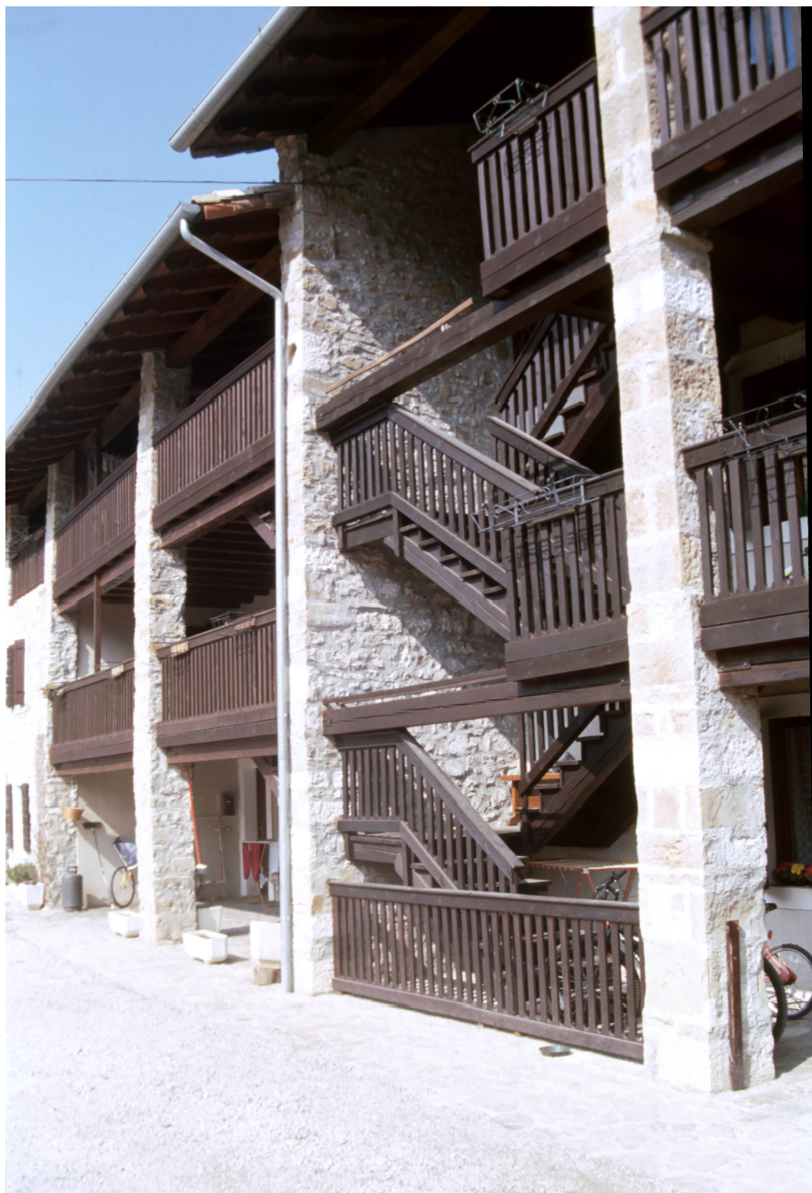
Esempio di tipo di casa a ballatoi su pilastri in pietra nella località di Frisanco (PN) nella Val Colvera. Si evidenzia il dettaglio della prima scala di accesso ai piani superiori in questo caso in legno, poiché ricostruita a seguito degli interventi post-sisma
