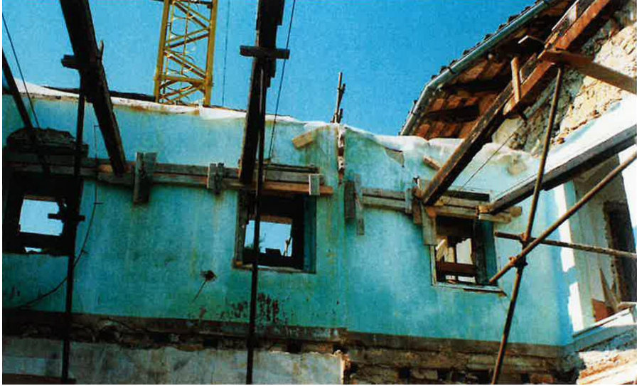
Fig. 36 - Puntellamento della muratura di un edificio a seguito della rimozione del solaio interpiano
