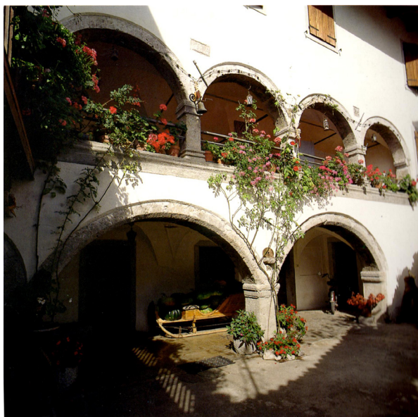
Casa carnica a Piano D'arta caratterizzata dai due porticati distributivi frontali con sovrapposizione di arcate. Il prospetto presenta i tipici due archi al piano terra sovrastati da quattro arcate e la scala di collegamento nel lato destro
