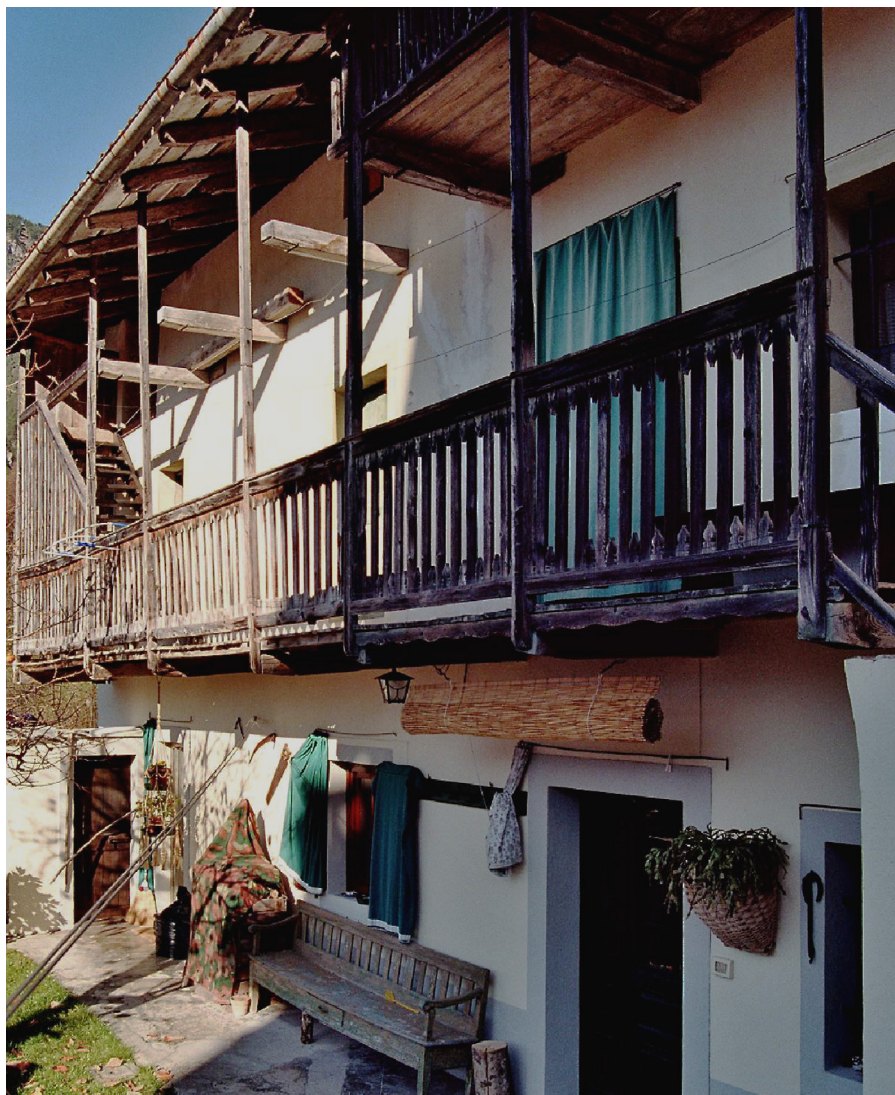
Esempio di casa a ballatoio situata nei piccoli agglomerati rurali della Val Resia. Particolare di ballatoio a sbalzo su mensola lignea e sorretto da montanti lignei fissati ai falsi puntoni della copertura in legno
