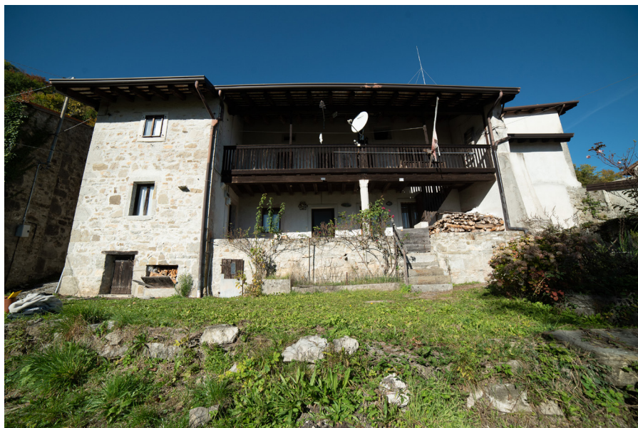
Casa a ballatoio con avancorpi situata nelle Valli del Natisone, in particolare nella località di Calla Superiore. Vista del prospetto principale esposto a sud
