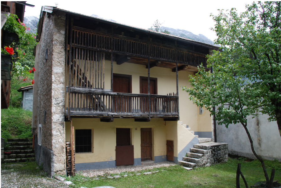
Esempio di casa a ballatoio situata nei piccoli agglomerati rurali della Val Resia, dopo un intervento di recupero
