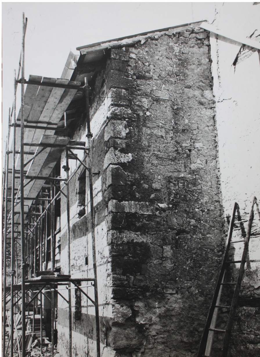
Fig. 3 - Il cantiere della ricostruzione. Una foto di un cantiere di recupero nel Comune di Pulfero (UD) nell'agosto del 1976
