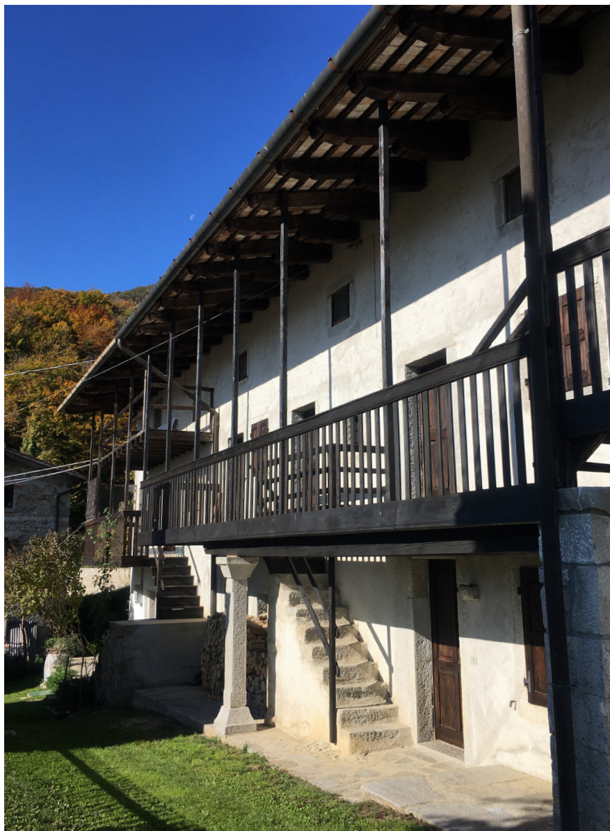
Fig. 7 - Casa a ballatoio in località Dorbolò (Valli del Natisone), risulta evidente la proporzione dello sporto di gronda realizzato per coprire tutto lo spazio distributivo del ballatoio. Questo edificio è caratterizzato da pilastri in pietra e scala in pietra per il collegamento verticale al ballatoio
