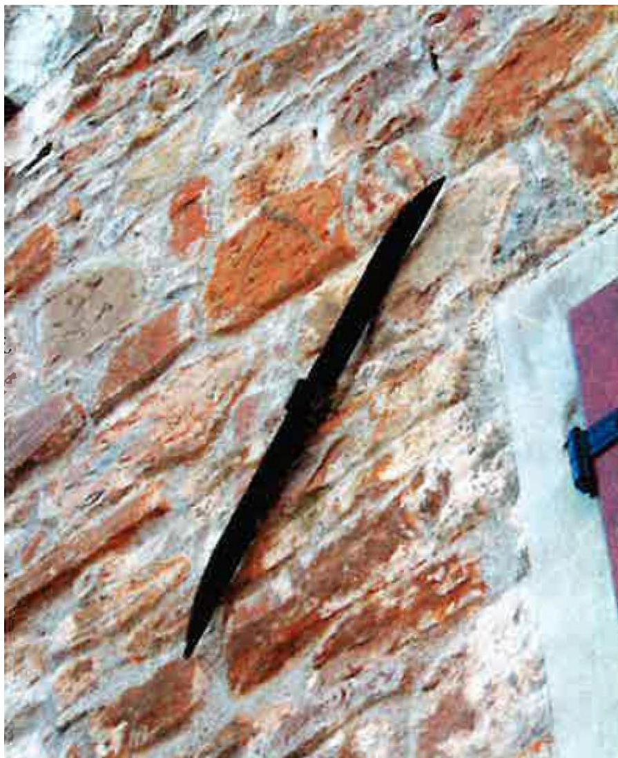
Fig. 32 - Esempio di capochiave del tipo a paletto
