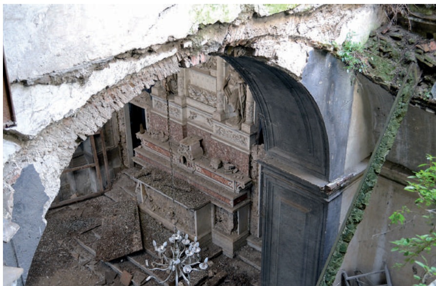
Fig. 17 – Aversa, Ospedale Psichiatrico “Santa Maria Maddalena”, la chiesa di Santa Maria Maddalena. Particolare dell’interno con l’altare maggiore e il crollo della copertura [foto di E. Manzo, 2012].
