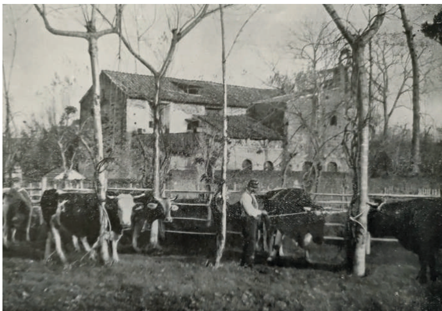
Fig. 53 – Aversa, Ospedale Psichiatrico “Santa Maria Maddalena”. Viale della Colonia agricola e Vaccheria in una foto storica degli inizi del Novecento [da Cascella, 1913].
