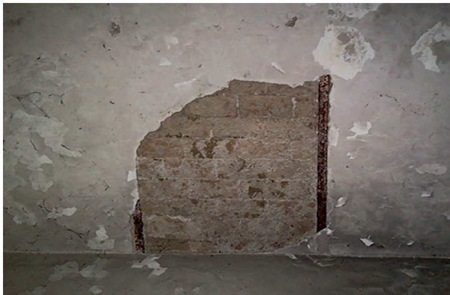
Fig. 43 – Aversa, Ospedale Psichiatrico “Santa Maria Maddalena”. Padiglione Verga, dettaglio costruttivo del solaio [foto di M. D’Aprile, 2024].
