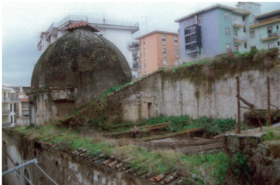
Fig. 64 – Aversa, chiesa di Santa Maria di Montevergine, la cupola e parte dell'ex monastero omonimo, poi sezione distaccata femminile delle Reali Case de' Matti [foto fornita dall'ingegnere R. D'Aniello].
