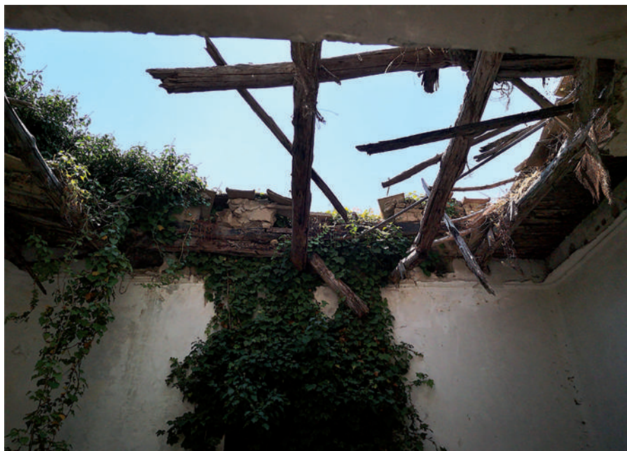
Fig. 44 – Aversa, Ospedale Psichiatrico “Santa Maria Maddalena”. Padiglione Verga, particolari del crollo del solaio [foto di M. D’Aprile, 2024].
