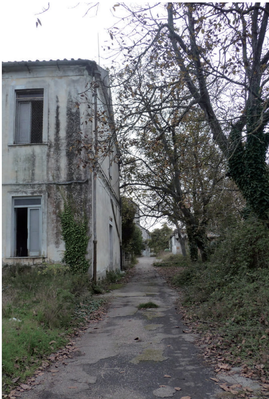
Fig. 40 – Aversa, Ospedale Psichiatrico “Santa Maria Maddalena”. Viali esterni tra i padiglioni [foto di E. Manzo, 2012].
