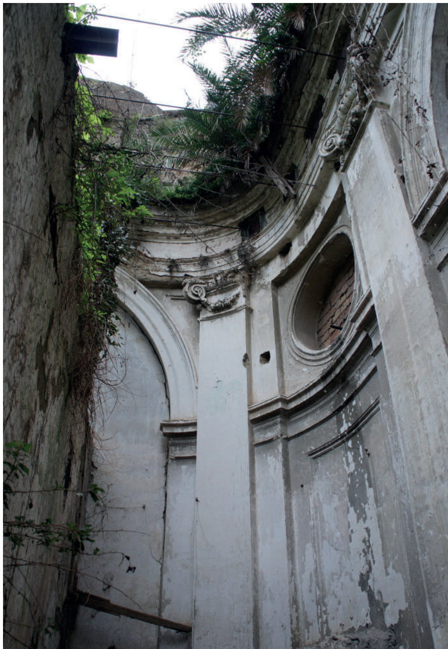
Fig. 63 – Aversa, chiesa di Santa Maria di Montevergine, già parte della sezione distaccata femminile delle Reali Case de' Matti. Abside [foto di R. Serraglio, 2024].
