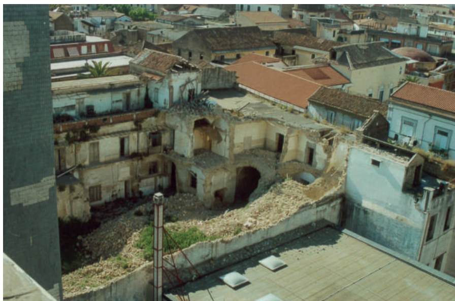
Fig. 66 – Aversa, Sezione distaccata femminile delle Reali Case de' Matti, già monastero di Santa Maria di Montevergine [foto fornita dall'ingegnere R. D'Aniello].
