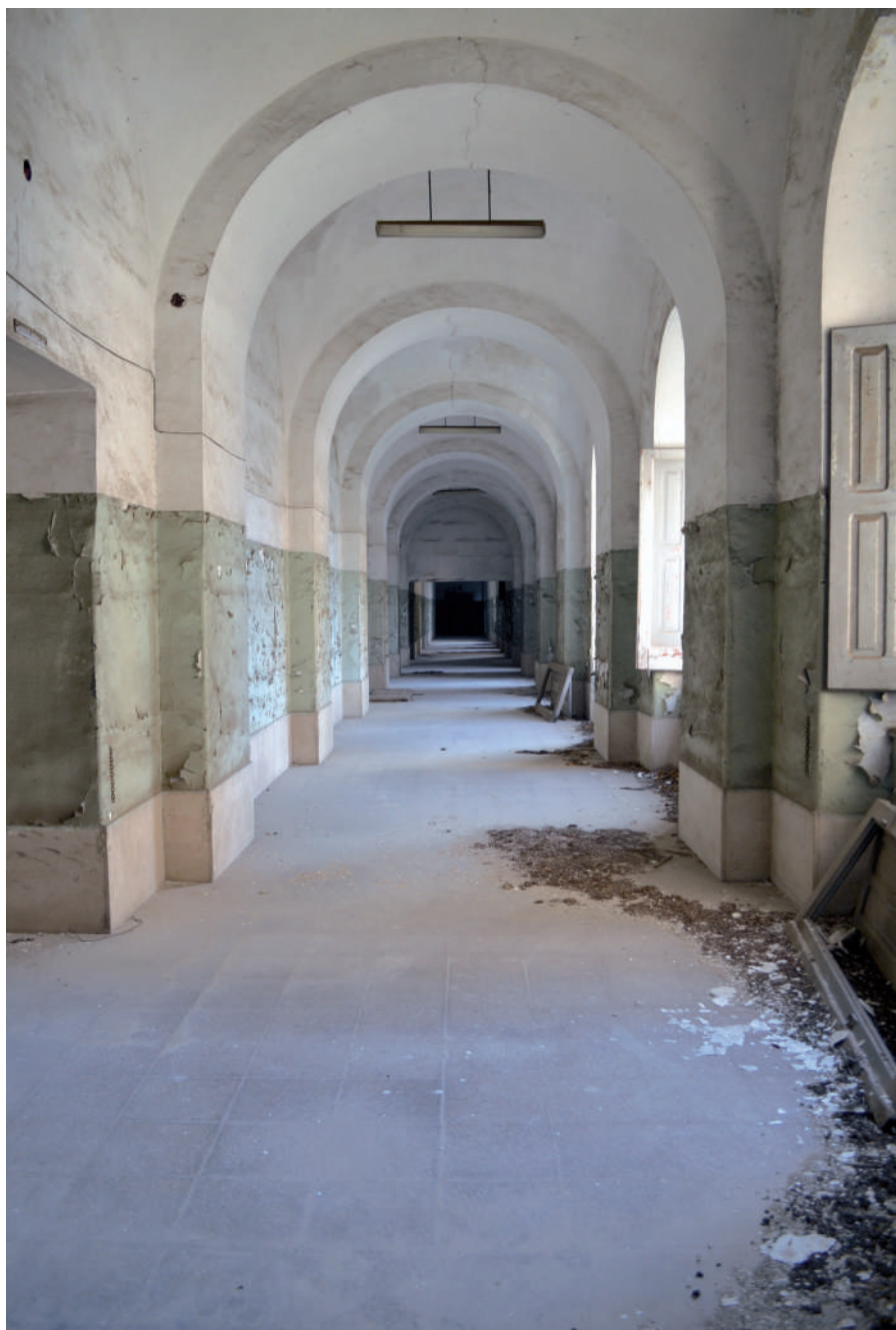
Fig. 9 – Aversa, Ospedale Psichiatrico “Santa Maria Maddalena”, corridoio al primo piano della Casa Centrale [foto di E. Manzo, 2012].
