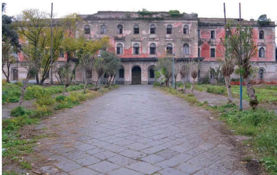
Fig. 2 – Aversa, Ospedale Psichiatrico “Santa Maria Maddalena”, la facciata principale della Casa Centrale [foto di E. Manzo, 2024].
