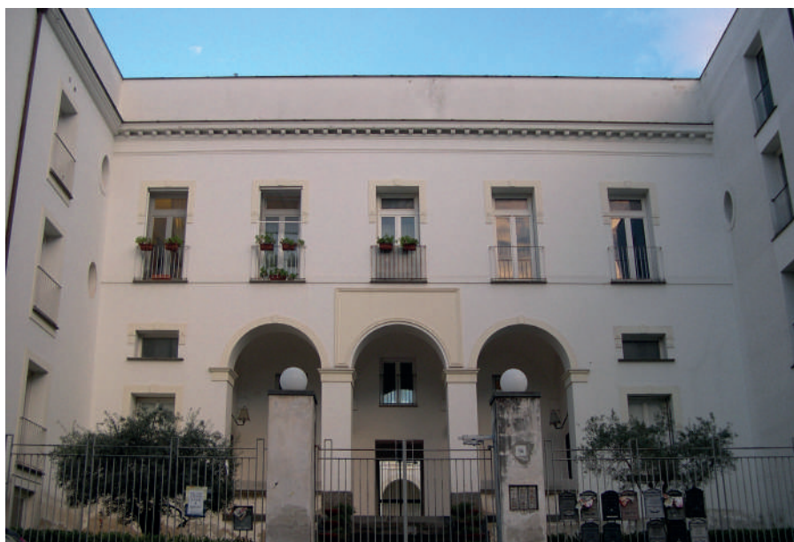
Fig. 68 – Aversa, Condominio Sant'Agostino (già convento di Sant'Agostino e, poi, sede succursale delle Reali Case de' Matti). Prospetto occidentale [foto di E. Manzo, 2024].
