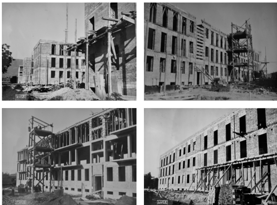
Fig. 76 - Le fasi di costruzione delle case, si evidenzia l'impiego di calcestruzzo armato per le strutture (ASDMAE)
