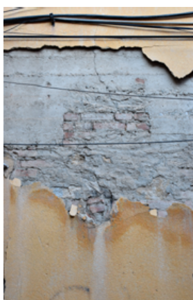
Fig. 93 - Case dei sottoufficiali, foto della matericit  costruttiva e del degrado
