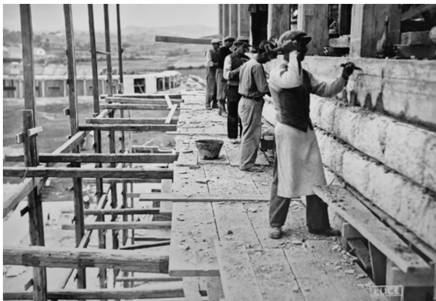
Fig. 13 - La Casa del Fascio a Tirana in costruzione, preparazione per la posa del rivestimento bugnato in travertino (ASDMAE)
