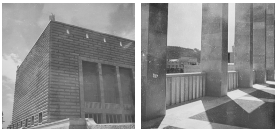
Fig. 16 - Il dettaglio della soluzione d'angolo e il basamento. A destra la balastrina in marmo ed il disegno della pavimentazione in cotto del loggiato (ASDMAE)
