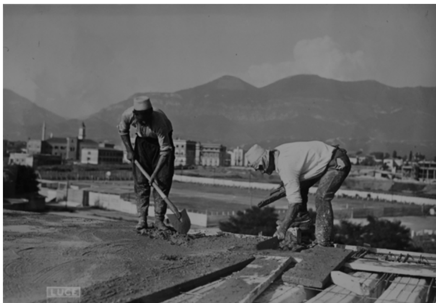
Fig. 78 - Le fasi di costruzione, il completamento della soletta del solaio laterocementizio tipo SAP (ASDMAE)
