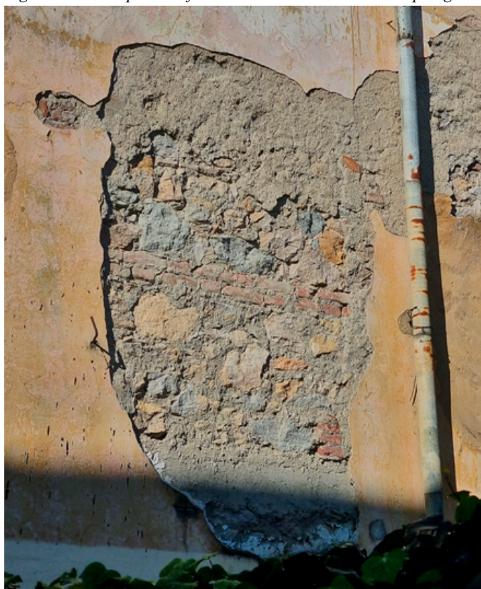
Fig. 72 - La consistenza materico-costruttiva dei paramenti murari emersa a causa della mancanza dell'intonaco
