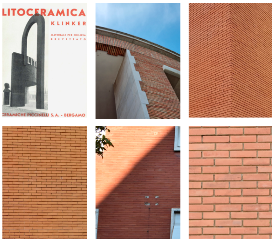
Fig. 40 - Litoceramica e Laterizio impiegati come rivestimento sia dei monumenti, come la Banca Nazionale d'Albania, sia delle case. Litoceramica - «Domus», n. 67, 1933
