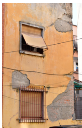
Fig. 93 - Case dei sottoufficiali, foto della matericit  costruttiva e del degrado
