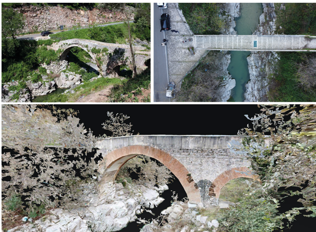
Fig. 5. In senso orario, immagine precedente al restauro, restituzione da drone, nuvola da laser scanning.
