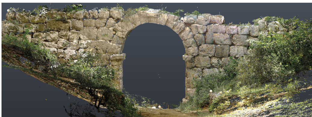
Fig. 2. Terrestrial Laser Scanning dell'Arco di Trevi (elaborazione grafica a cura degli autori).
