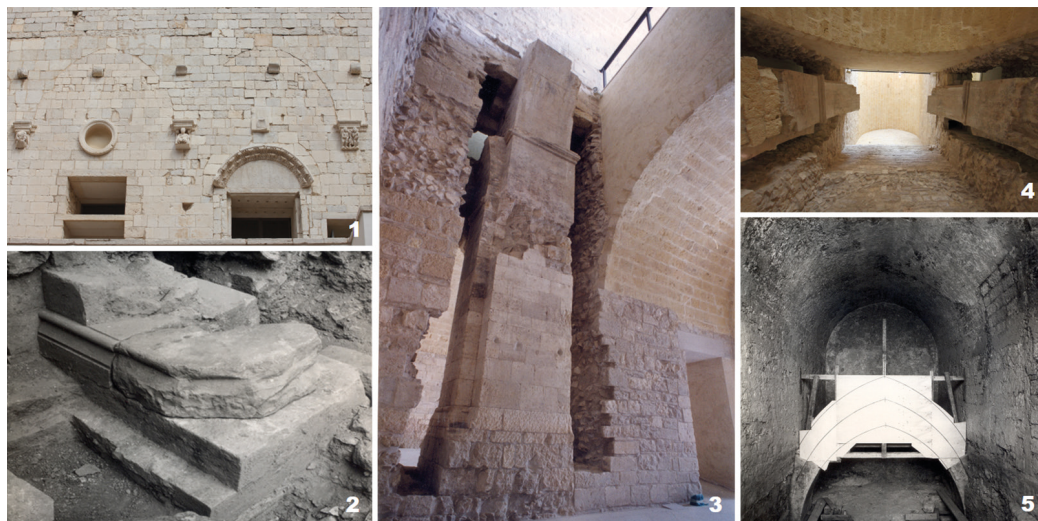
Fig. 5. Elementi superstiti del loggiato nord: tracce sulla cortina muraria dei rinfianchi delle volte a crociera ogivale e peducci d'imposta figurati (1); plinto a terminazione ottagonale di innesto sulla muratura dell'ala ovest (2). Elementi superstiti del portico sud: pilastro inglobato nelle murature di spina delle 'casematte' cinquecentesche (3); arcata dopo e durante gli scavi, con la prova per il completamento del tracciato geometrico (4), (5). Immagini su concessione DRM PUG, Castello Svevo di Trani, TRANI (BT) (elaborazione immagini: autori).
