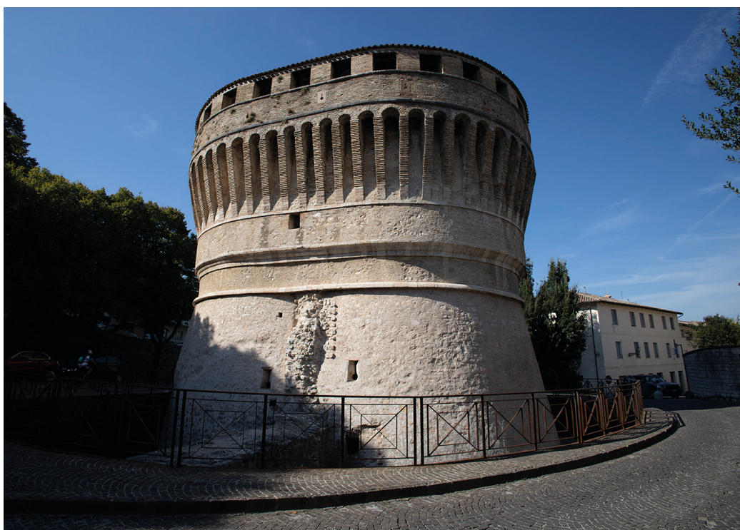
Fig. 5. Vista esterna della Torre Martiniana, Centro per la Scultura Contemporanea, Cagli (Pesaro-Urbino) (fotografia di G. Galvani).
