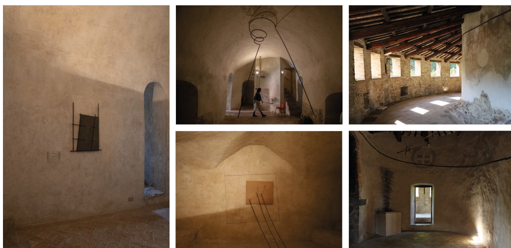
Fig. 1. Vista degli ambienti interni del Torrione che ospitano alcune opere di arte contemporanea (foto di G. Galvani, elaborazione grafica delle autrici).
