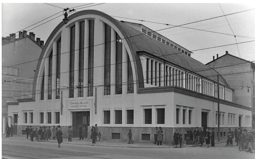
Fig. 7. La fotografia storica del mercato coperto di viale Monza mostra la struttura in cemento armato progettata dagli ingegneri Massari e Secchi nel 1933. L'edificio è uno dei due mercati coperti milanesi di inizio secolo sopravvissuti al periodo bellico (fonte: Off Campus NoLo).
