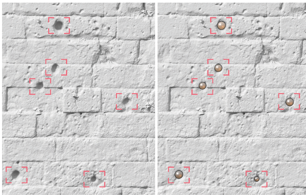
Fig. 3. Esempi di tracce balistiche documentate nel tratto di mura in prossimità di Porta Vesuvio e relativi proiettili impattanti (modelli di S. Bertacchi).
