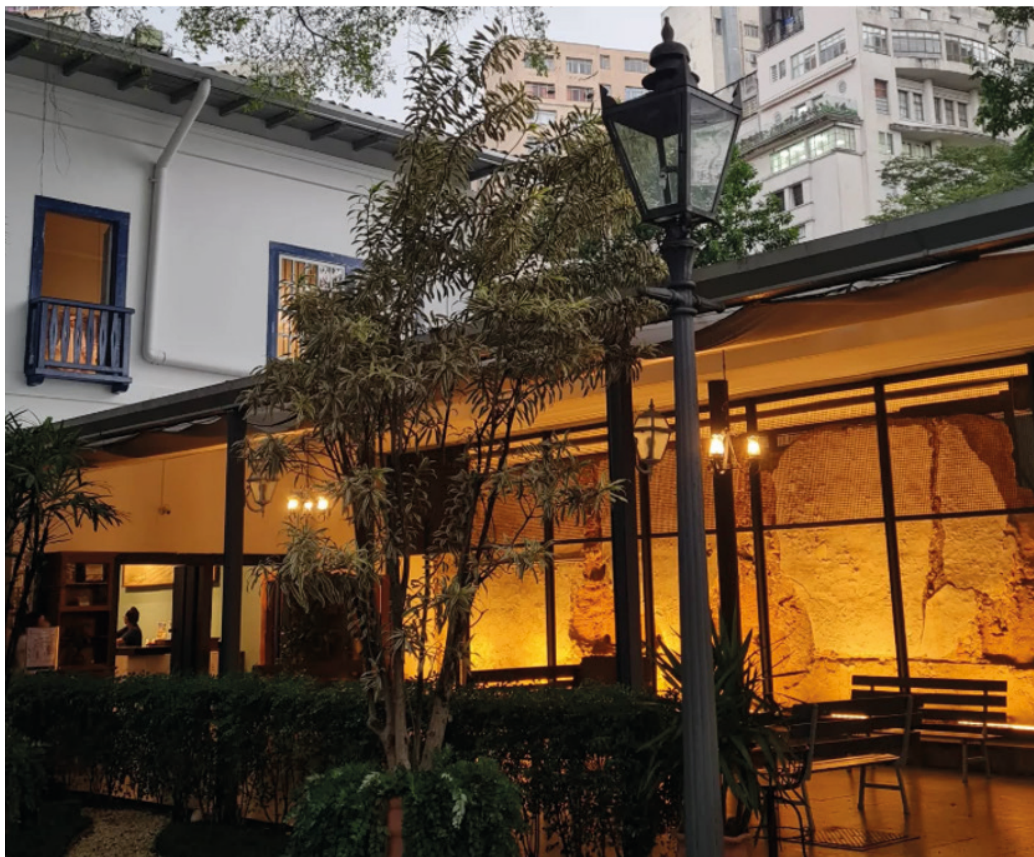
Fig. 11. Detalhe da estrutura em aço e pele de vidro para proteção da parede de taipa do Colégio dos jesuítas de São Paulo, datada do séc. XVI (perfil do Instagram do Pátio do Colégio, 2024, adaptado pelo autor).
