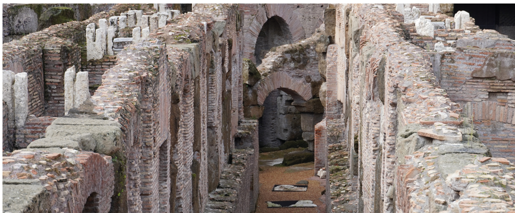
Fig. 1. Setti murari in opus testaceum che sostenevano il pavimento dell'arena del Colosseo (foto dell'autore).
