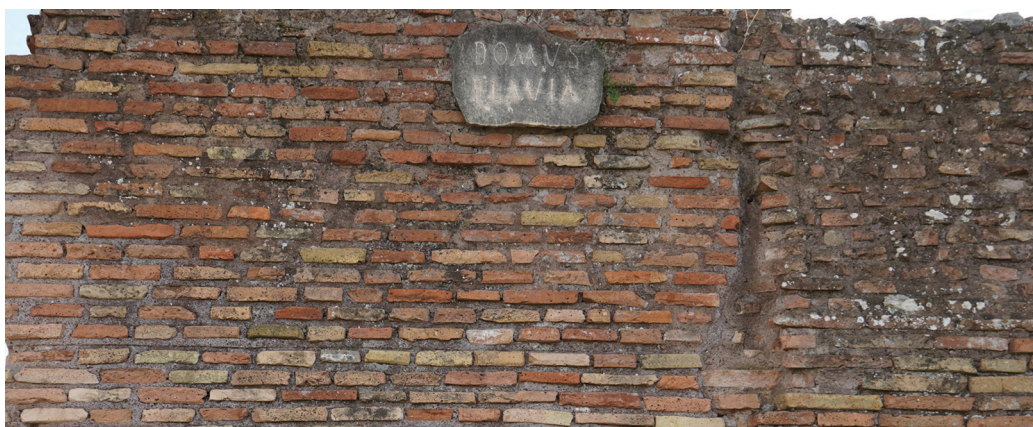
Parete est in opus testaceum del triclinio della domus Flavia sul Palatino (foto dell'autore).
