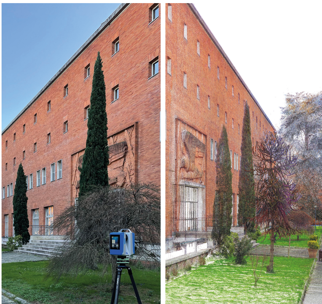
Fig. 3. Fasi di acquisizione dati mediante TLS e vista della nuvola di punti colorata della Palazzina Ufficiali (foto ed elaborazione grafica dell'autore).
