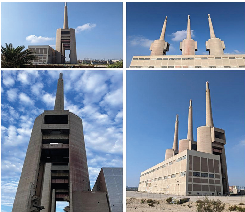
Fig. 1. Centrale termoelettrica di Sant Adrià de Besòs, Spagna. (fotografie di M. Proietti e F. Zollo).
