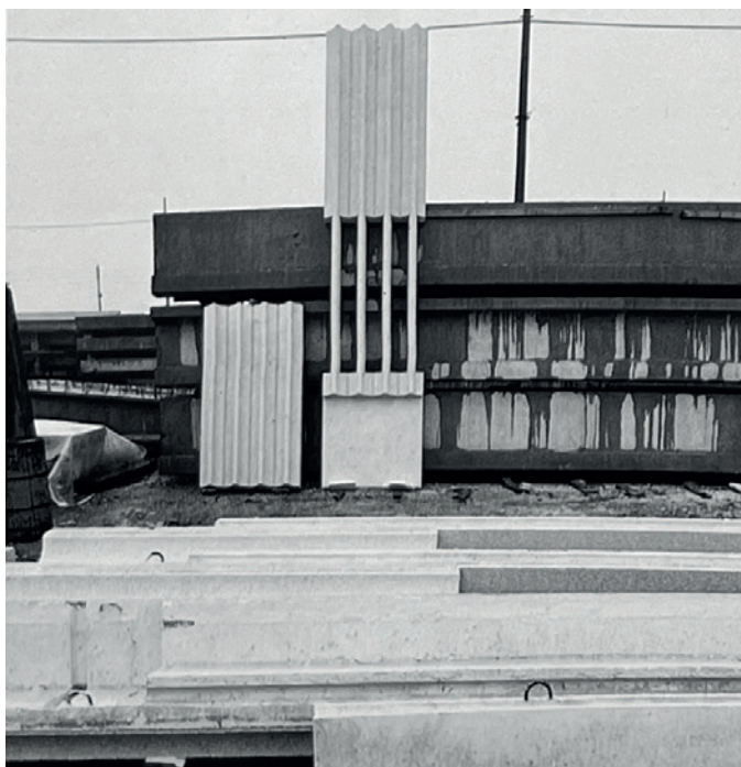
Fig. 34 - I pannelli pronti per il montaggio (Domus, 594, 1979)
