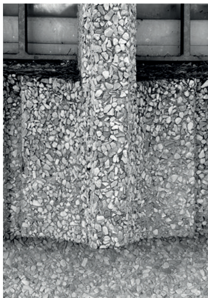
Figg. 24,25 - Ufficio postale di Atina (FR) 2025, dettaglio di un pannello prefabbricato. Ufficio postale di Civita Castellana (VT) 2025, Dettaglio dell'attacco a terra dei pannelli prefabbricati
