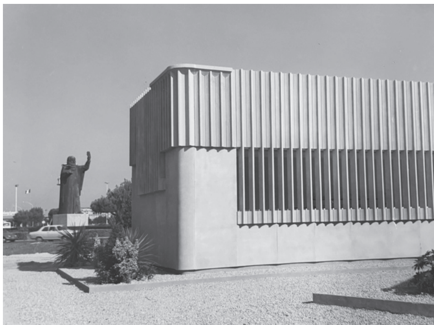
Figg. 3,4 - Il modello al vero costruito a Fiumicino (RM), in prossimità dell'aeroporto; si nota l'ipotesi di inserire un profilo sulla sommità dei pannelli (ASF, b. Foto 206-207)
