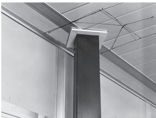
Figg. 12,13 - Dettagli del raccordo del pilastro con il divisorio e il controsoffitto (ASF, b. 147/206-207)
