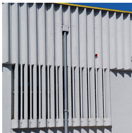
Figg. 13,14 - L'edificio di Acri è stato ristrutturato nel 2023; i pannelli sono stati tinteggiati di bianco, sono stati inseriti la scossalina a protezione della testa degli elementi, nuovi discendenti e sostituiti gli infissi
