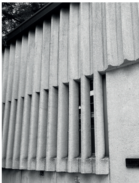
Figg. 3,4 - Ufficio di Cinquefrondi (RC), 2025. I caratteri originari sono stati modificati da interventi successivi, con l'inserimento di una scossalina e di una copertura in lamiera, i cui caratteri differiscono significativamente dalle indicazioni tipologiche del progetto-programma
