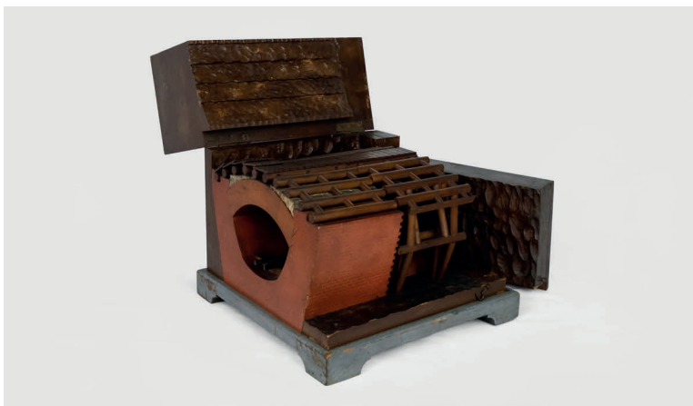
Fig. 22 - Modello didattico di armatura per la costruzione di galleria, apribile, 1865-1887, docente Giovanni Curioni di “Costruzioni civili, idrauliche, stradali”, modellatore Giovanni Blotto, Collezione Curioni, DISEG, Politecnico di Torino.
