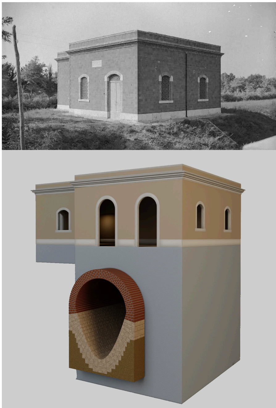
Fig. 14 – Vista dell'esterno del manufatto di scarico del collettore sinistro (in alto) ASR, USTAR, II, Lastre, Scatola 115; vista del modello geometrico-parametrico dello stesso manufatto, con l'intersezione con il tratto condotto sottostante (in basso).
