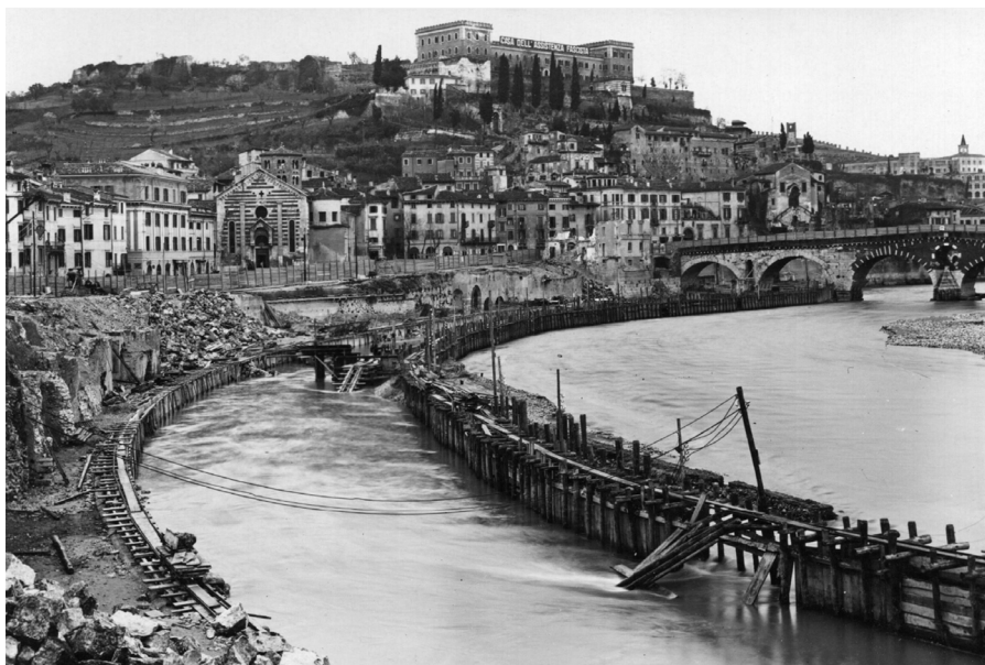
Figg. 9-10 – L'Archivio del Genio Civile dello Stato: la documentazione conservata nel fondo comprende anche una grande quantità di immagini relative ai lavori di inalveamento del tronco urbano dell'Adige, in particolare quelli svolti tra la fine degli anni '20 e la seconda metà degli anni '30. ASVr; Fondo Genio Civile, scatola 13.
