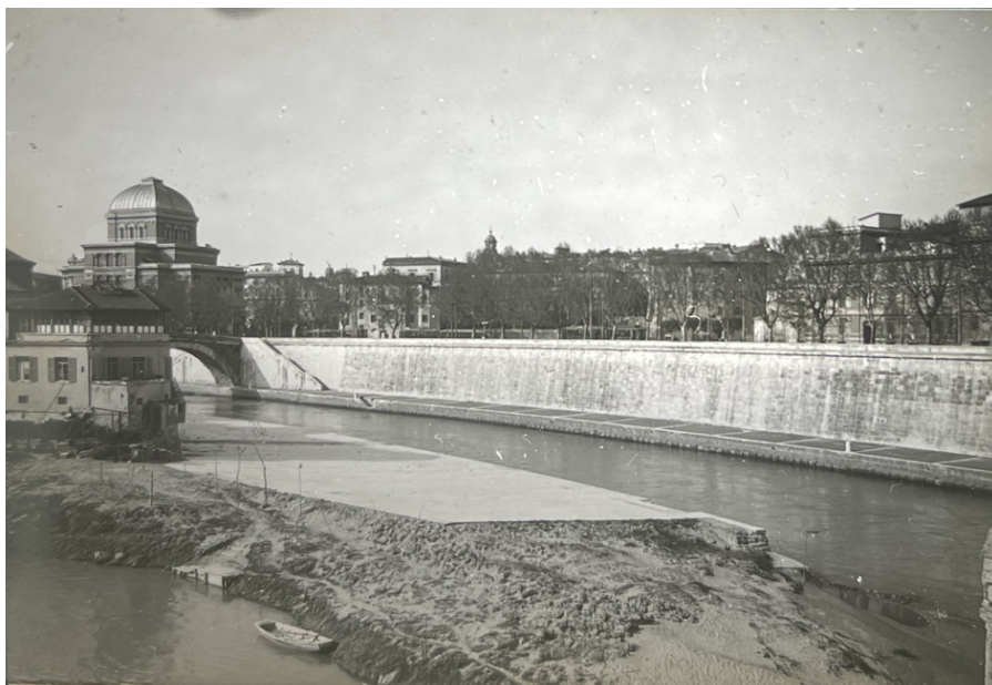
Fig. 3 – Riprese delle sponde del Tevere con i nuovi muraglioni e le banchine di approdo in costruzione in corrispondenza dell'isola tiberina, s.d, ASR, USTAR, Il versamento, lastre, scatola 252.
