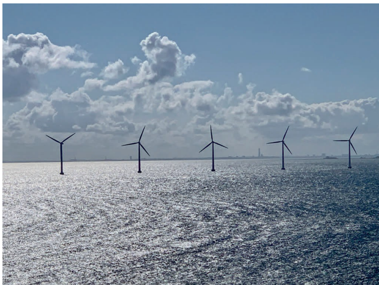
Fig. 1.3 - Turbine di impianto eolico off shore. La ridotta rugosità superficiale dell'acqua consente una maggior velocità del vento, con maggiore produzione di energia. Inoltre, il posizionamento in ambito marino consente di minimizzare l'effetto dell'impatto acustico prodotto. Foto degli autori
