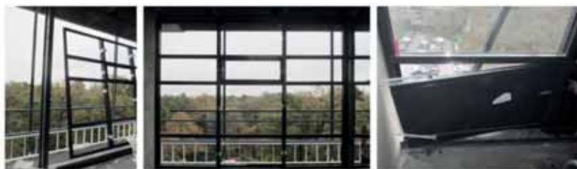
Fig. 7.27 – Ristrutturazione di un appartamento per studenti, interni al caso studio Hogeikamp a Enschede (Olanda), mediante l'installazione di nuovi componenti di facciata con tecnologie prefabbricate (Copyright 2018, H2020-INSITER Project Consortium Partnership)
