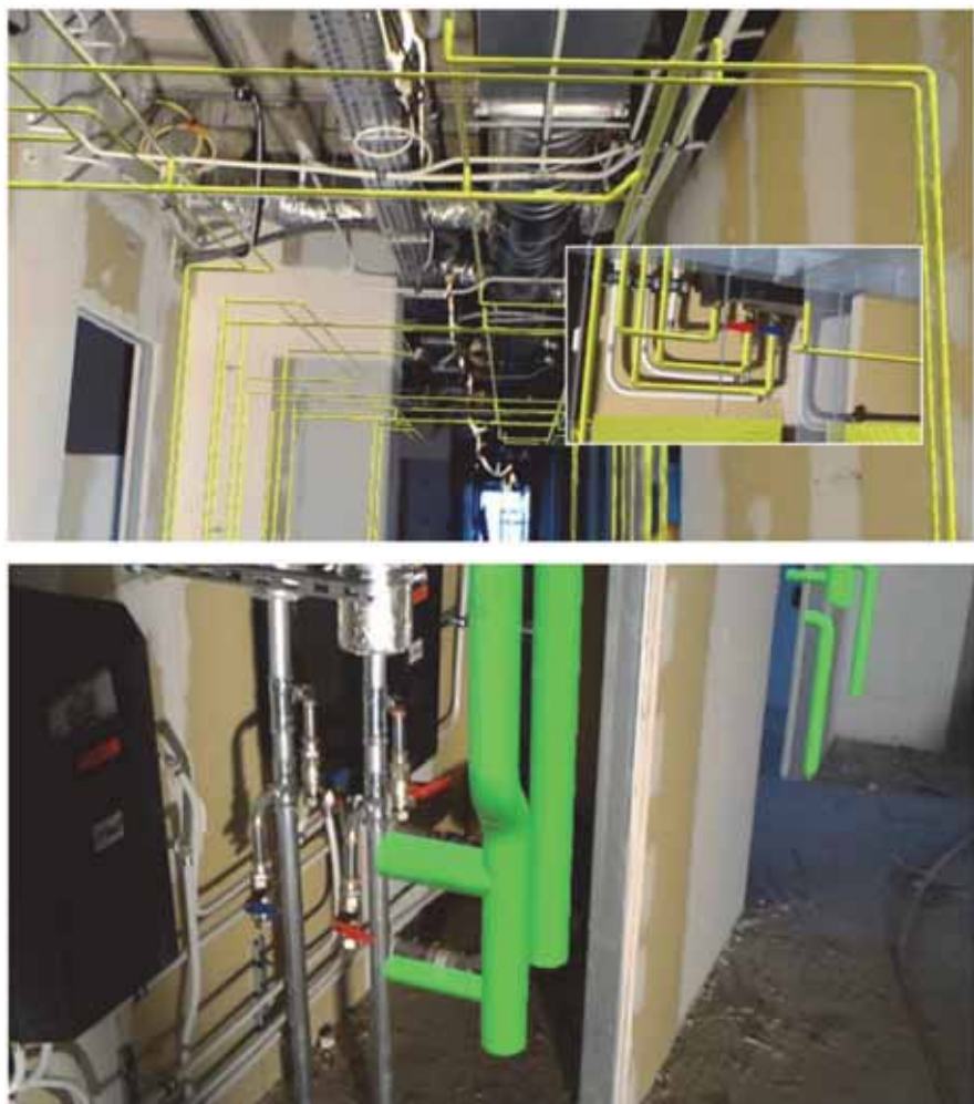
Figg. 7.30 (alla pagina precedente) e 7.31 – Applicazione di realtà mista basata su BIM INSITER con HoloLens; dimostrazione in sito sul caso studio HogeKamp, a Enschede (Olanda), focalizzata sui sistemi MEP, con funzioni di auto-istruzione e guida visiva per indicare dove gli elementi impiantistici devono essere installati nel contesto reale di cantiere (in questo caso: sistema di riscaldamento e distribuzione dell'acqua) (Copyright 2018, H2020-INSITER Project Consortium Partnership)
