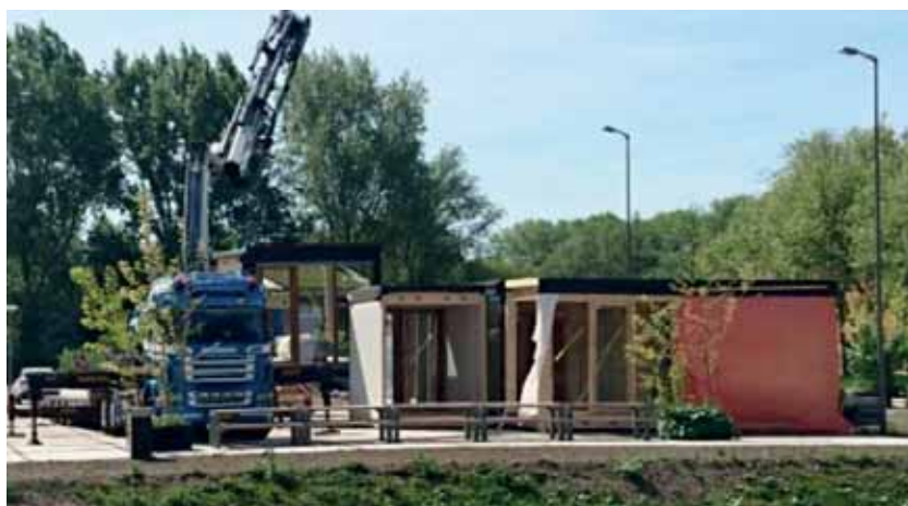
Fig. 7.16 – Realizzazione dei moduli residenziali del caso studio Green Villages – Sustainer Homes a Delft (Olanda). Le immagini mostrano il trasporto e l'assemblaggio in sito di unità prefabbricate in legno ad alta efficienza energetica, installate con tecniche di costruzione off-site e rapid on-site deployment (Copyright 2018, H2020-INSITER Project Consortium Partnership)
