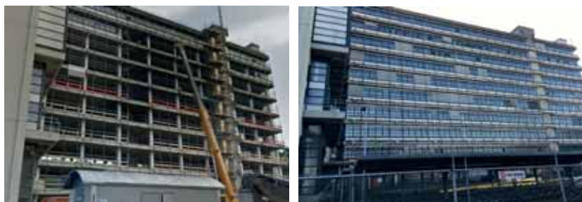
Fig. 7.24 – A sinistra, lo stato dell'edificio durante la profonda ristrutturazione; a destra, lo stato nel corso della deep renovation rivelando lo smantellamento degli elementi esistenti della facciata, insieme alla conservazione della struttura in cemento armato (Copyright 2018, H2020-INSITER Project Consortium Partnership)
