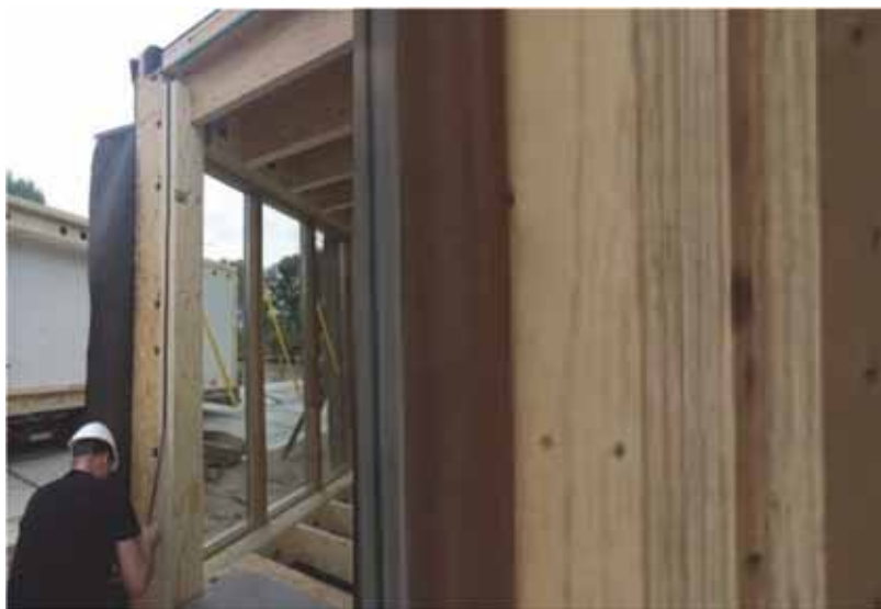
Fig. 7.18 – Prova dell’utilizzo di sigillante ermetico prima della posa del rivestimento e finitura finale nel caso studio Green Villages – Sustainer Homes a Delft (Olanda) (Copyright 2018, H2020-INSITER Project Consortium Partnership)
