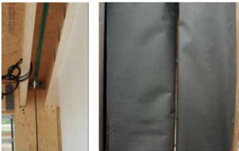
Fig. 7.17 – Esempio di situazioni in cui gli elementi non sono ancora connessi al 100% con evidenti problematiche di infiltrazioni di aria (Copyright 2018, H2020-INSITER Project Consortium Partnership)
