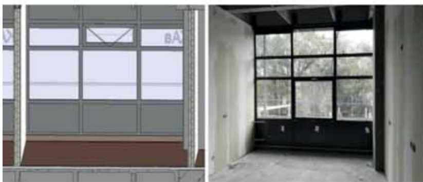
Fig. 7.34 – Confronto delle condizioni reali con il modello di progetto in BIM di un ambiente tipo del caso studio HogeKamp, a Enschede (Olanda) (Copyright 2018, H2020-INSITER Project Consortium Partnership)
