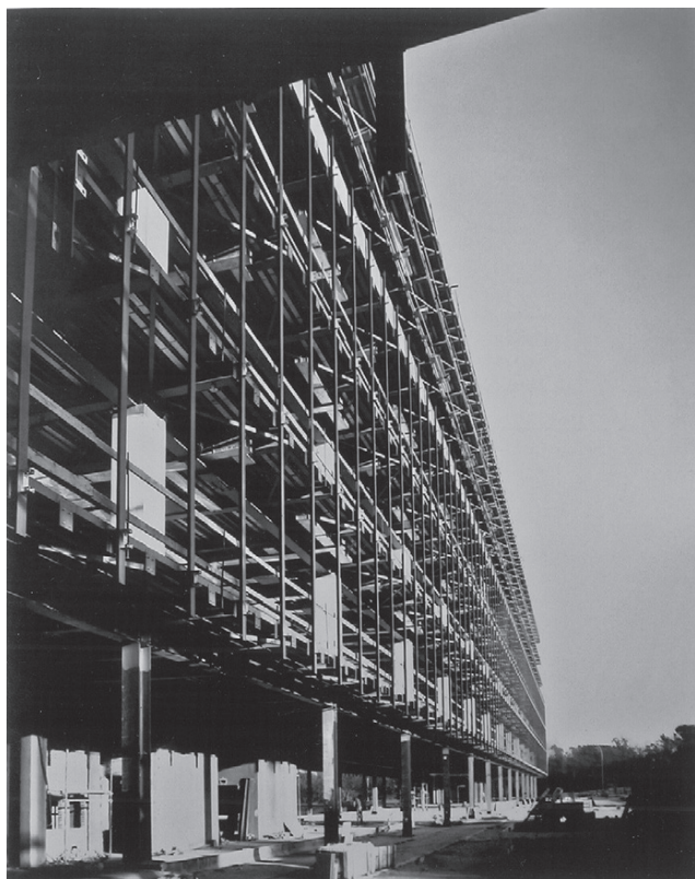
Fig. 19 - Uffici della Esso, montaggio delle pareti vetrate nelle fasi iniziali, ottobre 1965. Sono messi in opera solo i montanti di sostegno (ACS, SGIS, Album fotografici, b. 25)
