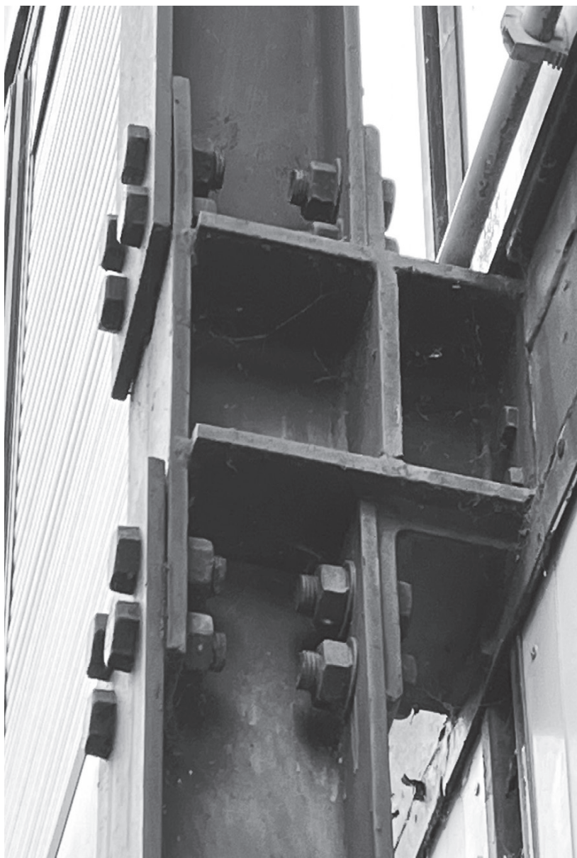
Fig. 18 - Istituto tecnico industriale di Tivoli: dettaglio del nodo della struttura portante esposto in facciata, 2024 (foto di A. Bologna)
