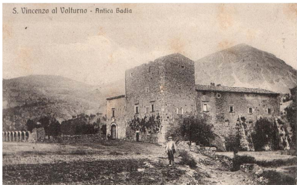
Fig. 16 - Abbazia Nuova. Il Palazzo Badiale prima dei restauri del dopoguerra in una cartolina di inizio XX secolo
