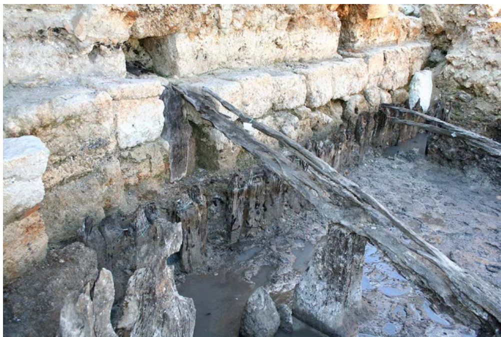
Fig. 32 - Le palificate in legno a protezione degli edifici sul Volturno (anno 2008) (foto F. Marazzi)
