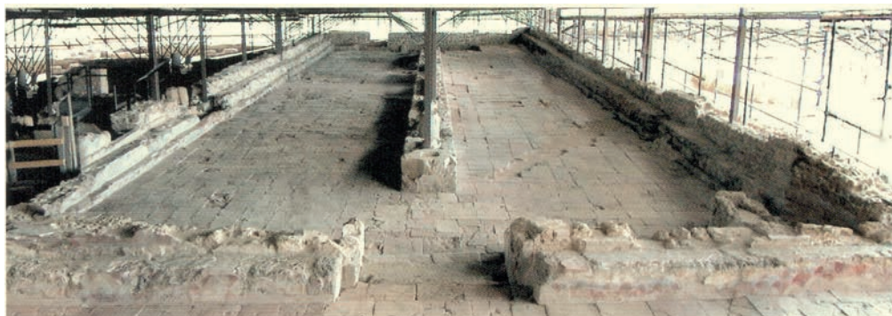
Fig. 57 - Veduta generale del refettorio da ovest (foto archivio LATEM)
