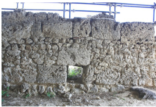
Fig. 2.2.5 - Dettaglio del muro che sorregge la scala di accesso alla basilica (foto di A. Frisetti)
