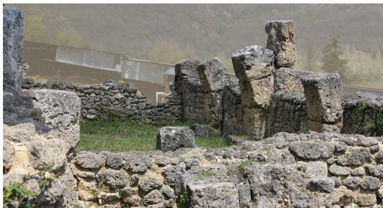
Fig. 2.2.8 - Corridoio lungo il colle: tecnica incerta che integra le pareti in travertino oggetto di tagli (foto da archivio LATEM)
