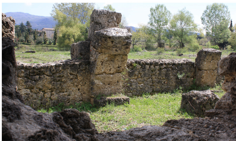
Fig. 2.2.10 - Sostruzioni per il ballatoio della scalinata di accesso alla Basilica: dettaglio degli innesti delle volte in grandi blocchi di travertino (foto di A. Frisetti)
