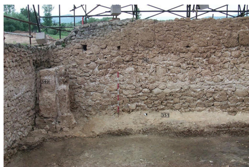
Fig. 2.2.1 - Parete in cortina di bozze di calcare e travertino di uno dei muri di fondazione dell'atrio della Basilica Maggiore (foto da archivio LATEM)
