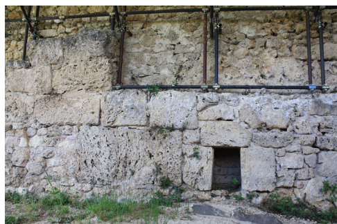
Fig. 2.1.4 - Tecnica a grandi blocchi nel muro est dell'atrio (foto di A. Frisetti)
