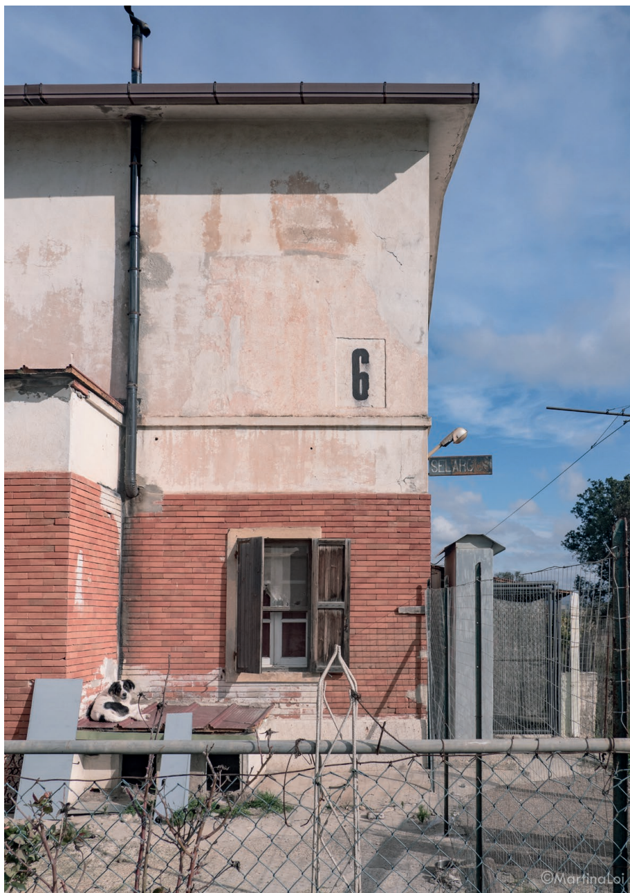
Fig. 4.4 (a pagina precedente). Rampe di accesso al ponte Emanuela Loi e abitanti più-che-umani Fig. 4.5. La stazione ferroviaria dismessa lungo la ferrovia a scartamento ridotto in agro di Monserrato
