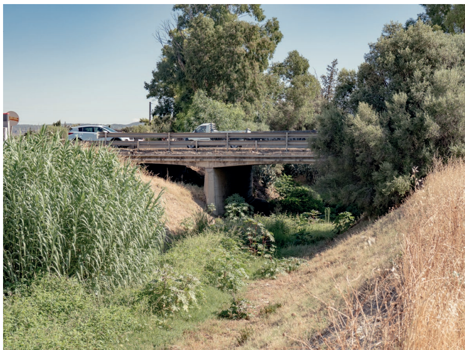
Fig. 4.38. Ponte tra il Riu Nou a Selargius e la SS 554
