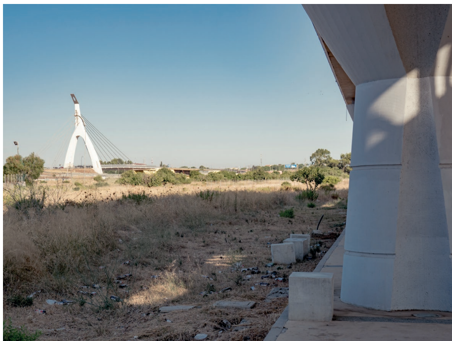
Fig. 5.11. Strutture della ferrovia sopraelevata e il Riu Saliu che le costeggia
