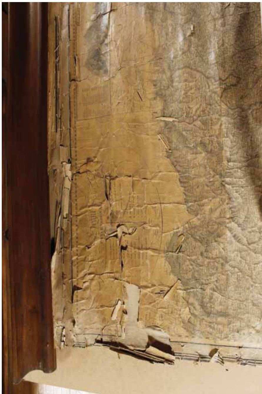
Fig. 2 – Particolare dell'area superiore dell'opera più soggetta a degrado meccanico.
