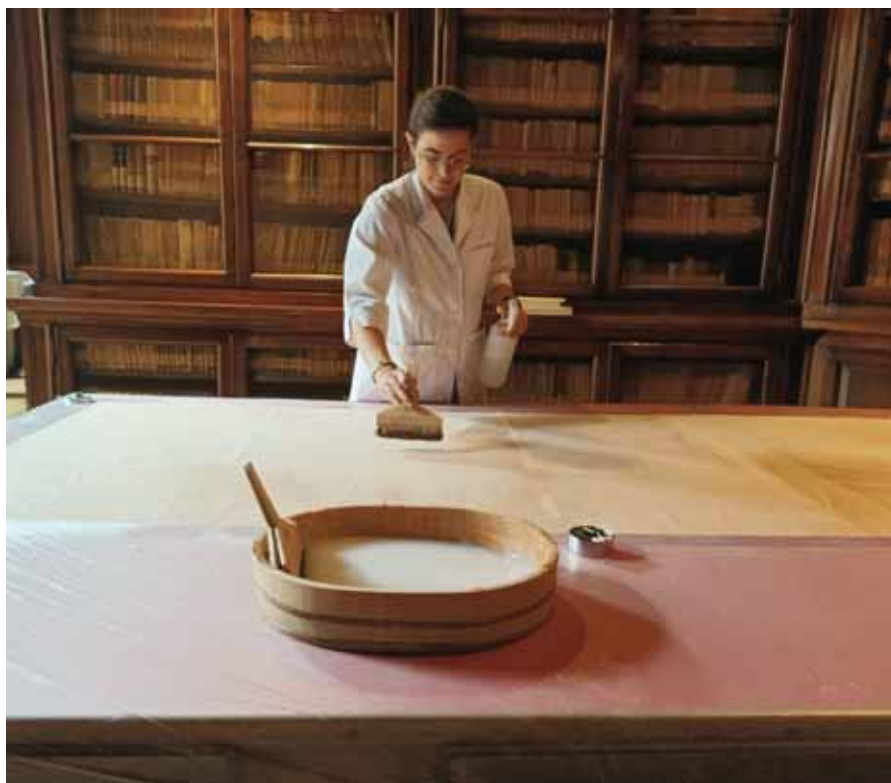
Fig. 13 – Applicazione della colla d'amido di grano Zin Shofu® sulle carte giapponesi con pennello Noribake.
