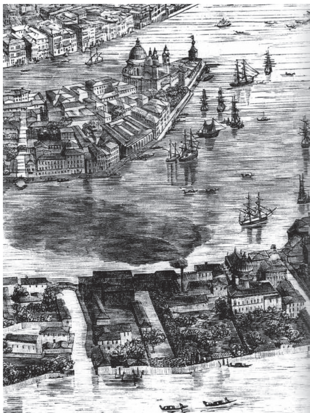
Figura 2. Venice. Vue a vol d'oiseau (particolare con la fabbrica di asfalto dei Rotschild alla Giudecca)
