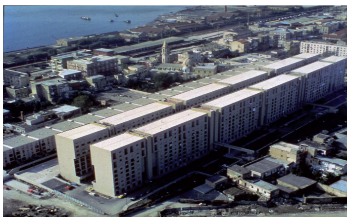
Fig. 1 - Immagine di repertorio del complesso di Taverna del Ferro vista dall'alto. Anno 1982
