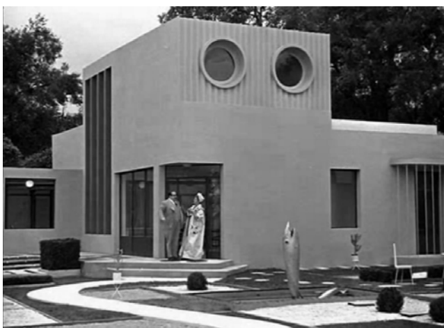
Fig. 1 – La casa Arpel e i due coniugi sulla soglia di casa.
