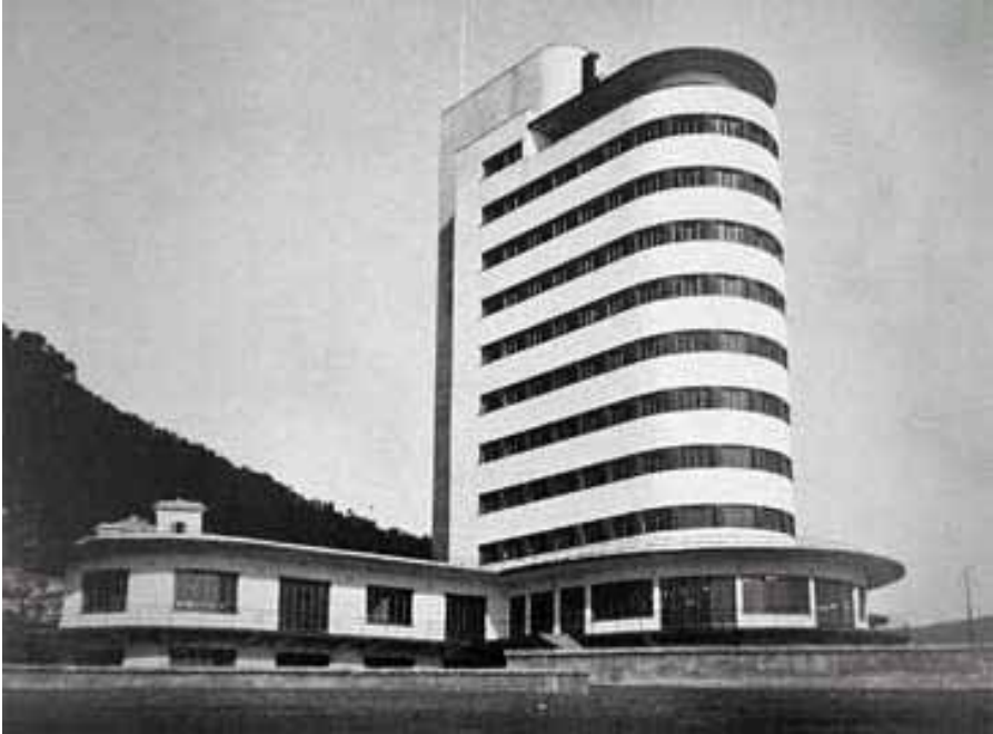
Fig. 07 : Fara Colonia in Chiavari (1935). Source: Labo'M, Podestà' A., "Colonie marine e montane", Costruzioni-Casabella , n. 167, November 1941, p. 16
