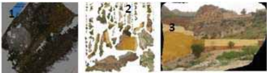
Fig. 09 : Acquisition et ortophotographie sur un site de l'hôpital Baudens. On observe clairement la menace géologique. Ce type de données spatiales nous a guidé vers un paramétrage de la corrélation (géologie /Habitat)
