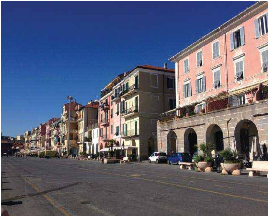
Fig. 03 : Vue des arcades du quai
