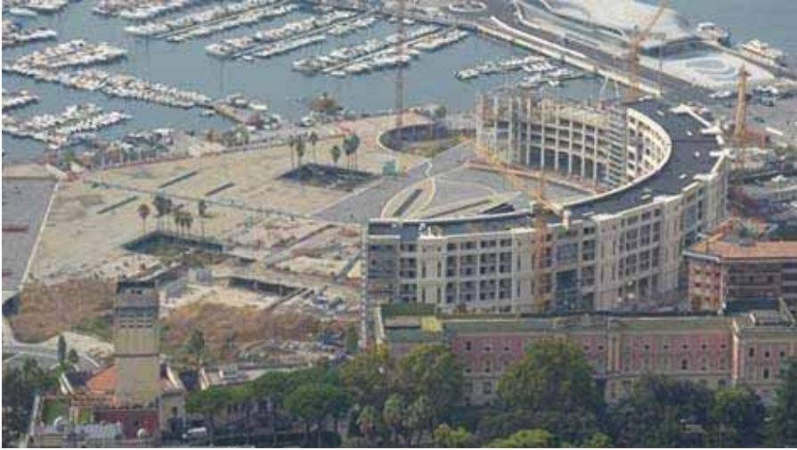
Fig. 07 : "Piazza della Libertà" and the "Crescent" under construction
