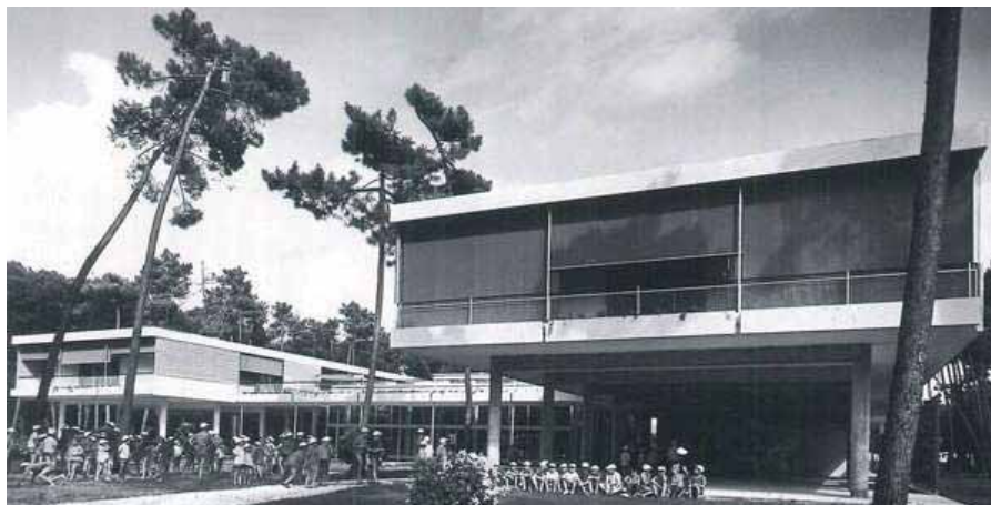
Fig. 03 : Olivetti, Marina di Massa (1948-1958), arch. A. Fiocchi Example of second post war period colonia. Source : Cibello L., Sudano P.M., Annibale Fiocchi architetto, AION Ed., Firenze, 2007, p. 42
