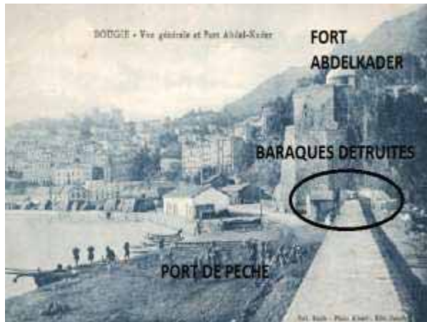
Fig. 08 : Baraques des pêcheurs démolies
