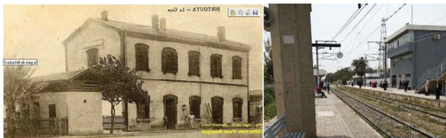
Fig. 09 : Etat des lieux de la gare Birtouta. Source : https://www.snff.dz + photo prise par l'auteur
