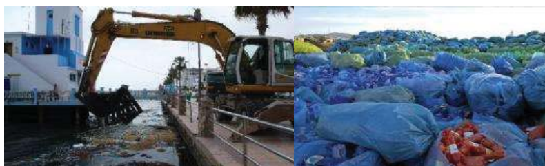
Fig. 03 : L'opération de dépollution de la lagune. Source : Site de l'agence pour l'aménagement du site de la lagune de Marchica
