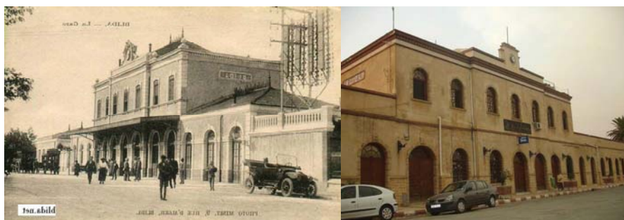
Fig.10 : Etat des lieux de la gare de Blida. Source : https://www.snff.dz + photo prise par l'auteur
