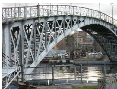
Fig. 03 : Revolving bridge (photo S. De Maestri)
