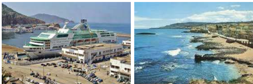
Fig.05/06 : Le nouveau quai de transport maritime(2015) - Erosion des plages
