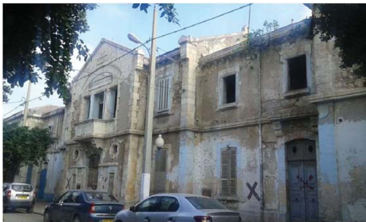
Fig. 08 : Photos de la façade principale de l'édifice, source : l'auteur
