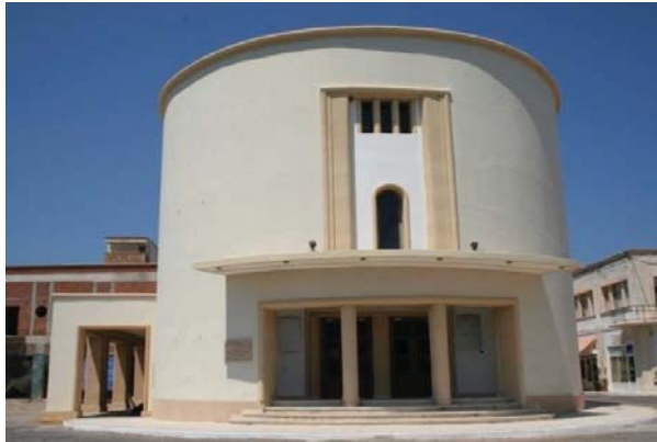
Fig. 06 : Le cinéma Léros après les travaux de restauration (© Giuseppe Mancini, 2015)
