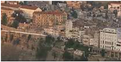
Fig. 05b : Vue du côté de la casbah
