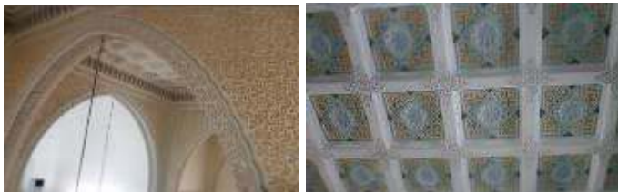
Fig. 15 : Décoration en stuc sculpté en bas-relief, le plafond de la nef centrale. L'église Sainte Marcienne (L'auteure, 2015)
