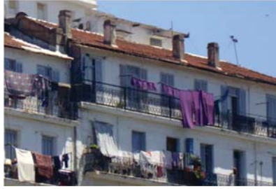
Fig. 01 : Toitures avec couverture en tuile sur charpente en bois et traversée par des cheminées
