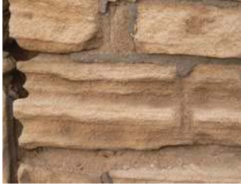
Fig. 09 : Au contact du mortier de ciment, la roche présente de profonds sillons qui creusent le matériau mettant en relief les niveaux les plus durs
