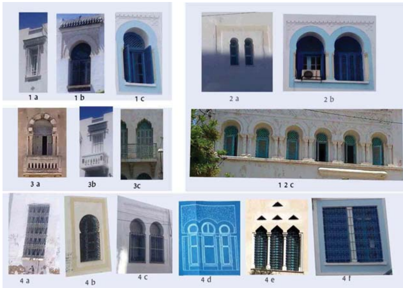
Fig. 02 : Les différents types de fenêtres au niveau des façades
