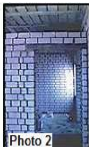
Photo. 01 : Murs porteurs (2DF), Photo. 02 : Murs de séparation (DF), Photo. 03 : Murs extérieurs sans crépissage. Source : Auteur, 1995
