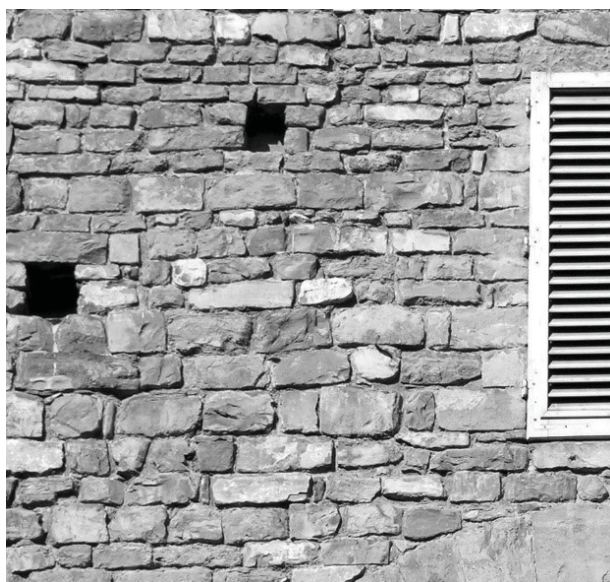
Fig. 08 : Grès quartzeux-calcaire (Pietraforte, Crétacé sup.) et grès quartzeux-feldspatique (Macigno, Oligocène) : Florence (Toscane septentrionale) (H5)
