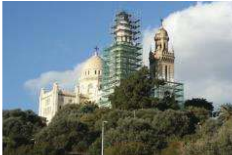
Fig. 04 : Travaux de restauration de la Basilique (2013), (source inconnue)
