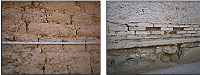
Fig. 08 : Appareillage du mur extérieur, source: Auteur, 2015. Fig. 09 : Soubassement du mur extérieur source: Auteur, 2015
