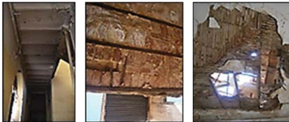
Fig. 10 : Système IPN Voutain au-dessus du couloir source: Auteur, 2015. Fig. 11 : Plafond IPN au-dessus de la cuisine source: Auteur, 2015. Fig. 12 : Faux plafond traditionnel source: Auteur, 2015
