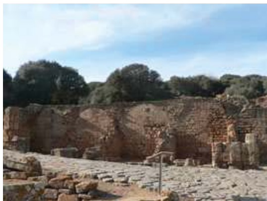
Fig. 04 : Boutiques du Capitole consolidées avec du mortier à base de ciment
