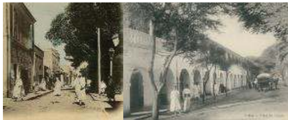
Fig. 04 : Alignement des arbres
