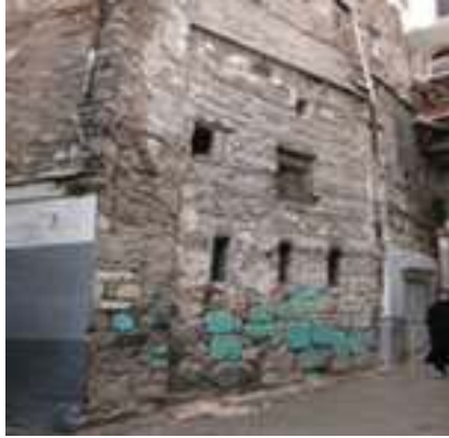
Fig.14 : Utilisation de la pierre romaine dans la réalisation des parties dans les constructions de l'époque arabe. Source : photo prise par l'auteur
