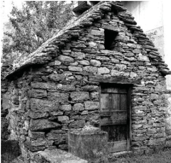
Fig. 12 : Orthogneiss du Monte Rosa (Prétriassique) : Montecrestese (valle Antigorio, VCO, Piémont septentrional) [L2]
