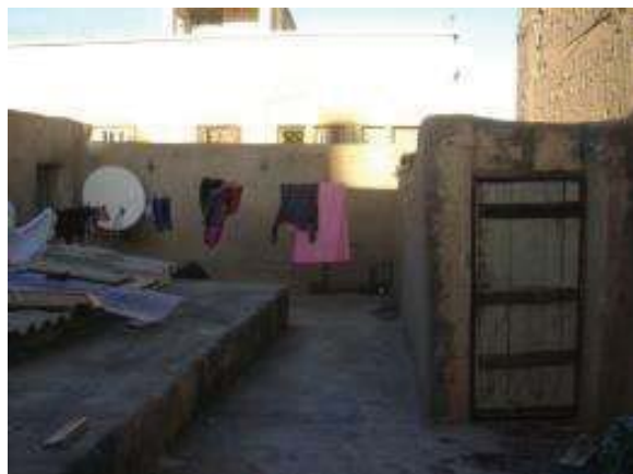
Fig.10 : Terrasse d'une maison coloniale
