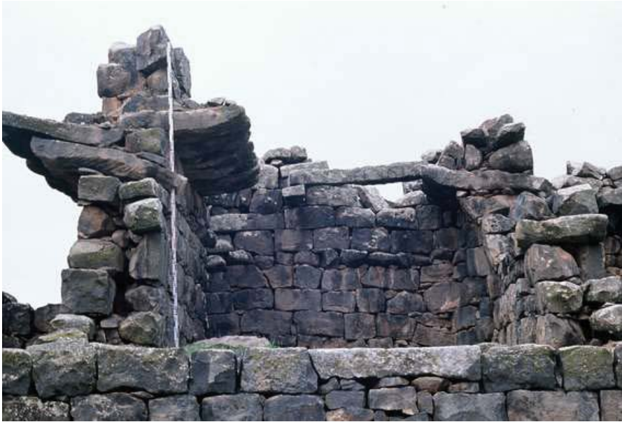
Fig. 02 : Le complexe système du dispositif de couverture d'une piège avec des barres et des solives en pierre de basalte supportées sur des consoles simples ou doubles intégrées dans la structure des murs périmétriques
