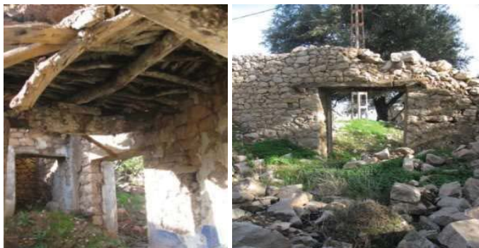
Fig. 06, 07 : Etat du bâti en 2017. Source : N.Baloul
