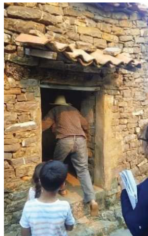
Fig. 02 : Positionnement des ouvertures et leurs dimensions de manière à ne jamais avoir un regard direct sur l'espace intérieur. Fig. 03 : Reconstitution des entrées vers l'une des maisons
