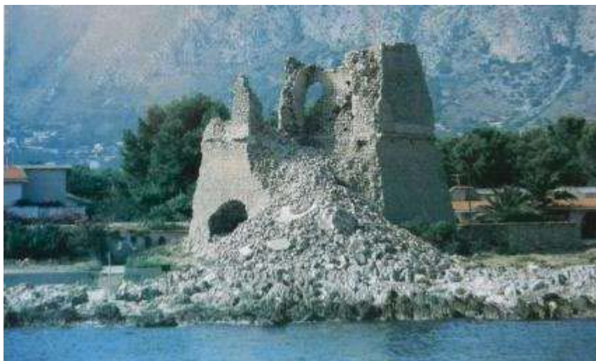
Fig. 17 : Fait de la tour il y a une dizaine d'années, vue de la mer
