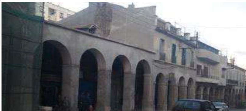
Fig. 12 : La façade qui donne sur la rue Didouche Mourad, pendant les travaux Source : Cliché Auteur 01/03/2017
