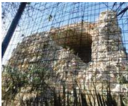
Fig. 18 : La tour aujourd'hui, on voit les restes de la voûte en berceau
