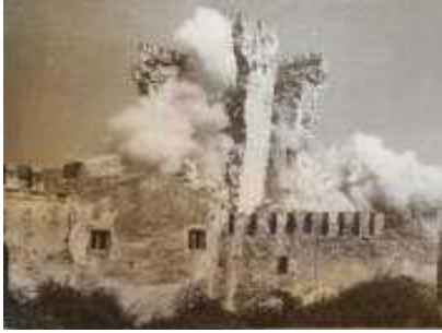
Fig. 13 : Chateau Cupane, Acquadolci (ME) pendant la destruction de la tour en 1966
