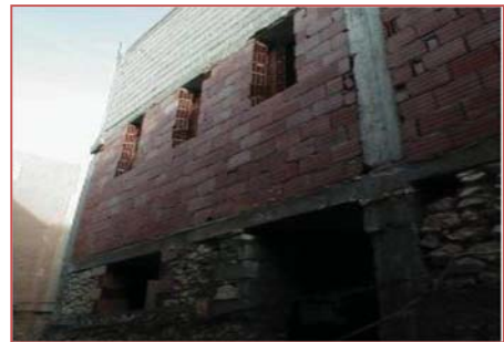
Fig. 02, 03 : Etat du cadre bâti dans la vallée : une maison reconstruite avec d'autres matériaux tels que la brique et le parpaing. Source : ZERTI BENDIF, mai 2005
