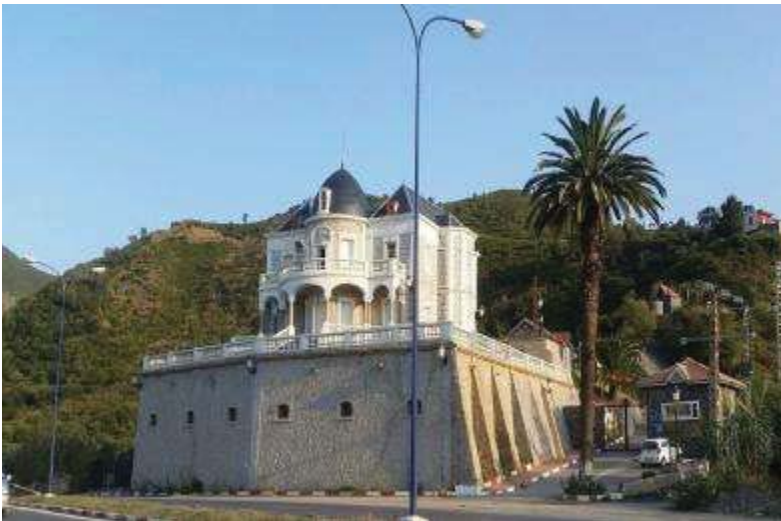
Fig. 01 : Le Château de la Comtesse après la réhabilitation 2017
