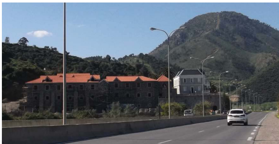
Fig. 04 : Une vue d'ensemble sur le domaine du château après la réhabilitation
