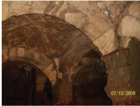
Fig. 02 : Voûtes d'arête couvrant la citerne (Photographie AUA)
