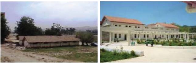
Fig. 05 a,b : Ferme Zérama avant et après réhabilitation
