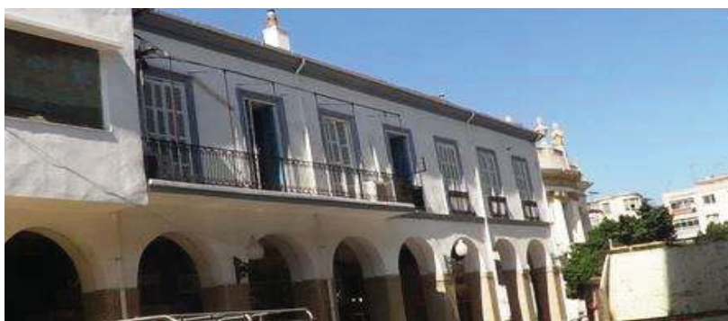
Fig. 13 : L'état actuel de la façade qui donne sur la rue Didouche Mourad, les travaux sont toujours en cours Source : Cliché Auteur 16/10/2017
