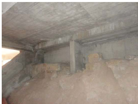
Fig. 04 : Vue sur les sous-sols de la mosquée après les travaux de 1963 (Photographie AUA)
