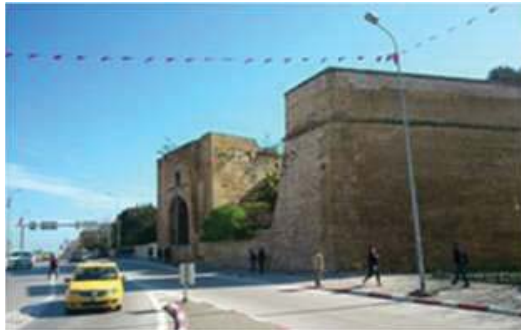
Fig.12 : Le site d'intervention (Photo : Badis Hadj Said, 2017)
