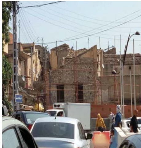
Fig. 04 : Installation électrique aérienne vieillissante et risque d'incendie, Source : Auteurs juillet 2017
