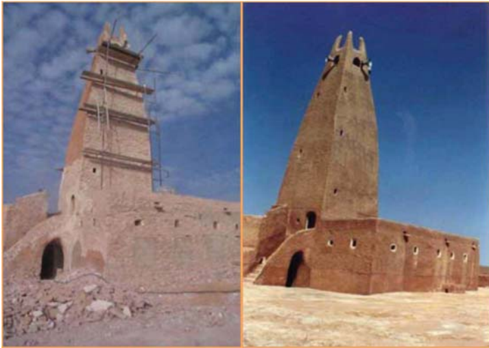
Fig. 06,07 : Vue sur la mosquée Bounoura avant et après la restauration. Source : BALLALOU, 2011
