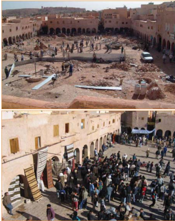
Fig. 04, 05 : Vue sur la place du souk avant et après la restauration. Source : BALLALOU, 2011
