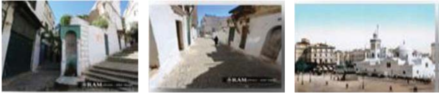
Fig. 01 : Le style du patrimoine urbain dans la région d'Alger (Kasbah).
