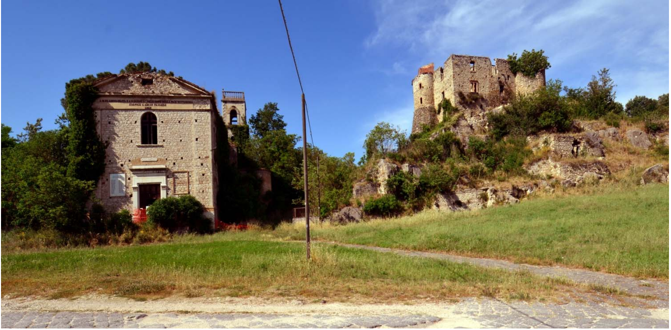
Fig. 2 – Melito Irpino. Ruederi della chiesa della Madonna Addolorata e di S. Egidio e del castello – Fonte: Giovanni Rossi Filangieri, www.esserealtrove.it/contenuti/urban-exploration/paesi-abbandonati-melito-irpino/
