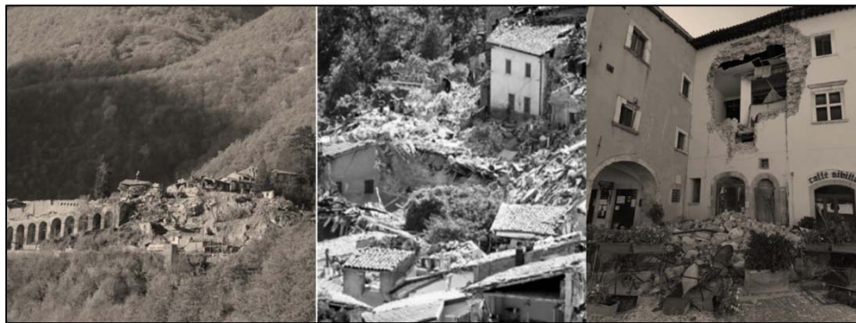
Fig. 4 - Arquata del Tronto (AP), Pretare di Arquata e Visso (MC): Gli effetti del Terremoto - Fonte: UCCR-Mar Mibac
