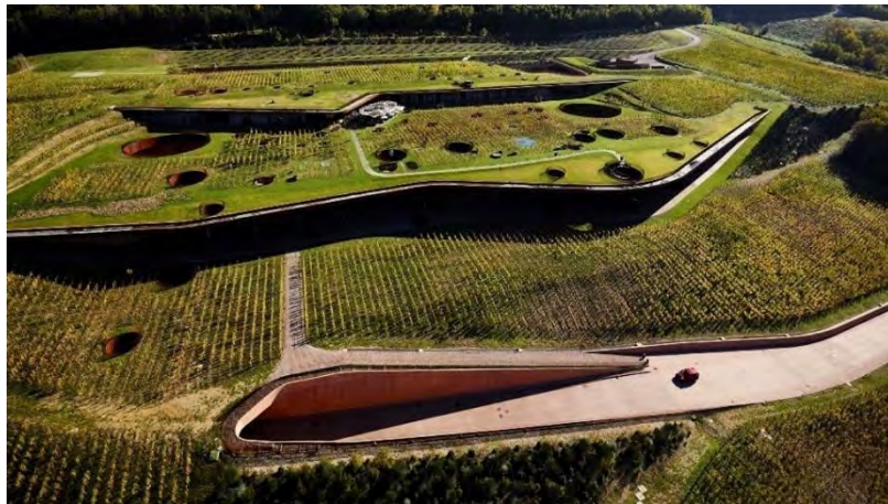
Fig. 2 – Cantina Antinori Bargino, San Casciano Val di Pesa, Firenze – 2004-2013 Studio ARCHEA Associati. La cantina è interrata ed inserita nel versante della collina attraverso due tagli che seguono le curve di livello.
