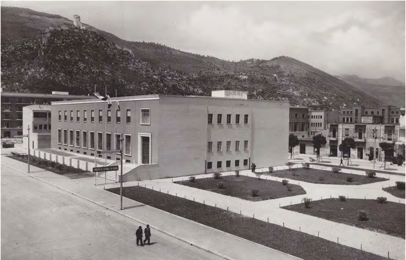
Fig. 3 – Il Palazzo di Giustizia di Cassino. G. Nicolosi. Vista d'insieme prima dell'edificio prima dell'ampliamento.
