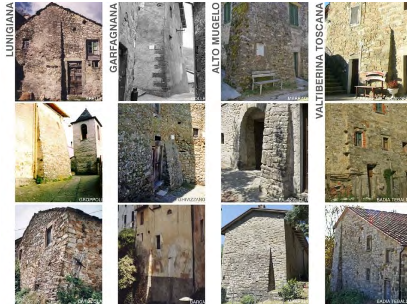
Fig.3 – Contrafforti e muri scarpanti nelle quattro aree di studio – Fonte: archivio Pierotti Ulivieri (elaborazione di Landi S.)
