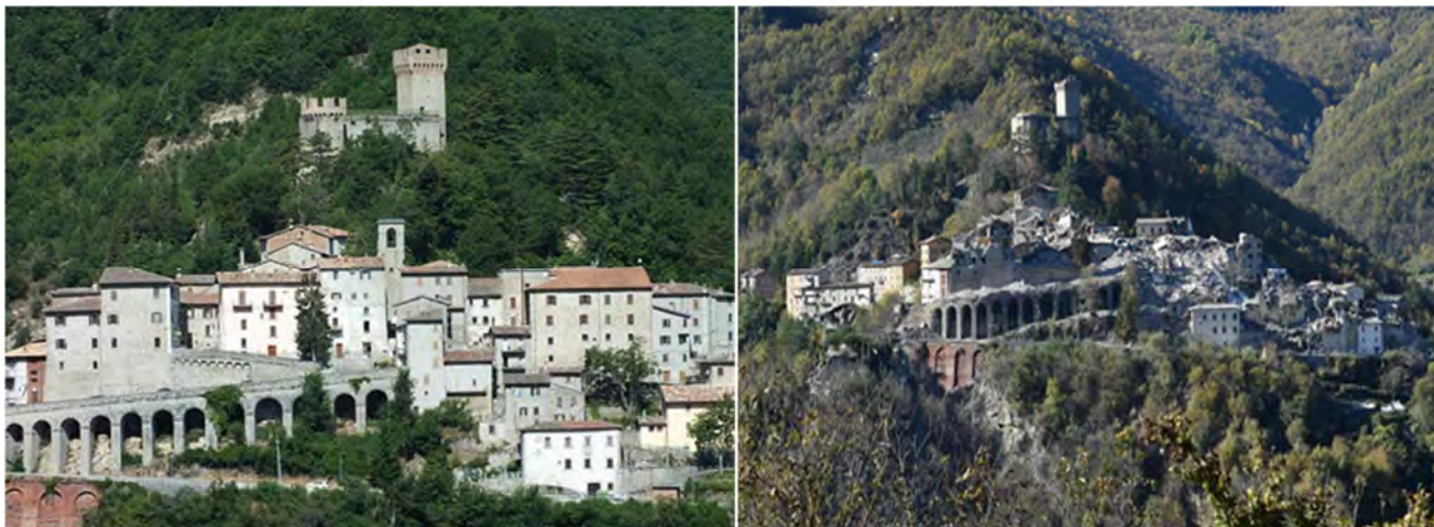
Figg. 2-3 – Veduta di Arquata del Tronto prima e dopo gli eventi sismici 2016-2017 – Fonte: foto di F. Riti
