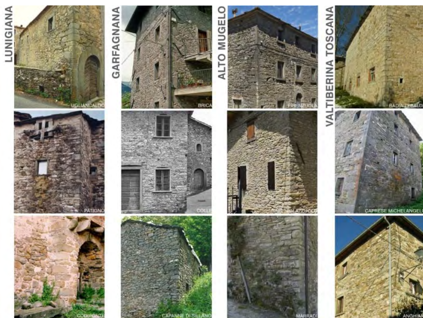
Fig.2 – Cantonali nelle quattro aree di studio – Fonte: archivio Pierotti Ulivieri (elaborazione di Landi S.)
