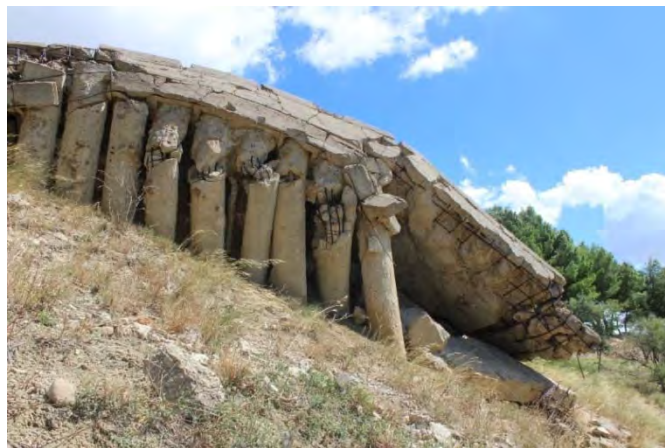
Fig. 5 – Vista del muro di sostegno realizzato nel 1970
