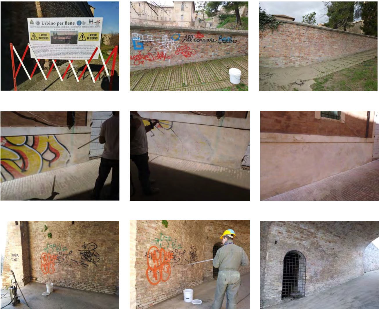
Fig. 8 – Alcuni interventi per la rimozione delle scritte vandaliche dalle superfici murarie – Fonte: Archivio Scuola di Conservazione e Restauro, 2017-2018
