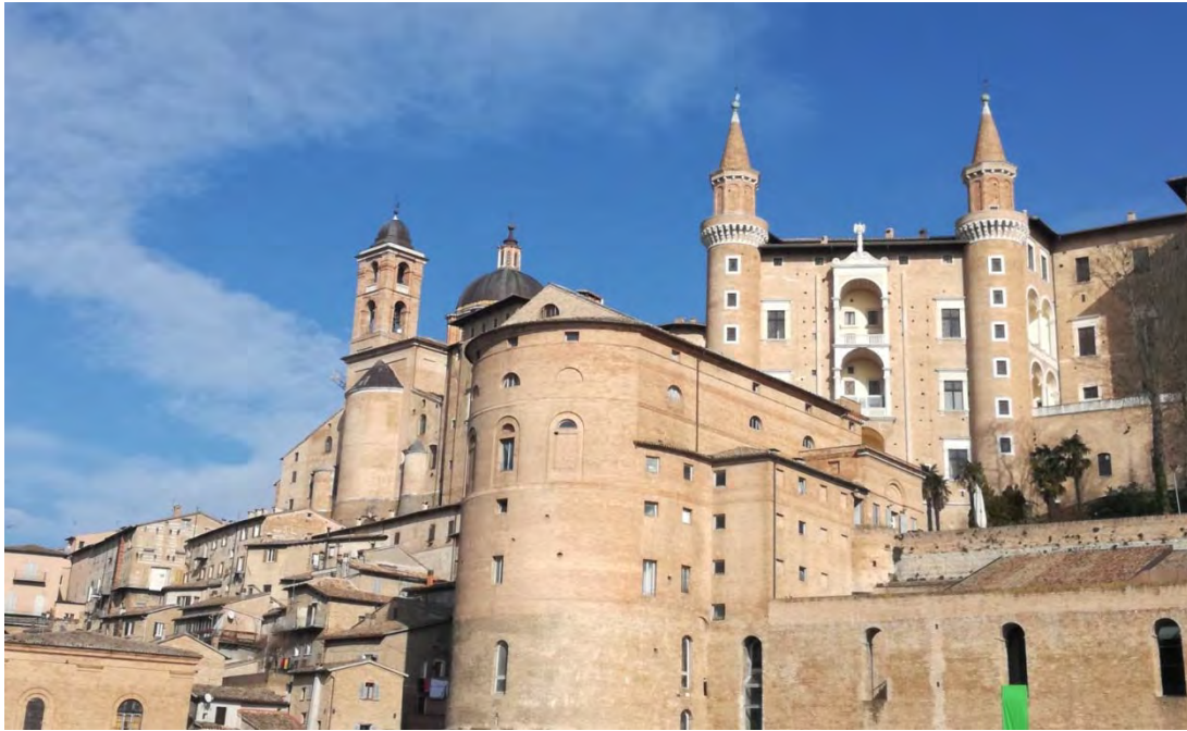
Fig. 10 – Veduta di Urbino da Piazzale Mercatale – Fonte: foto di Alessandra Cattaneo
