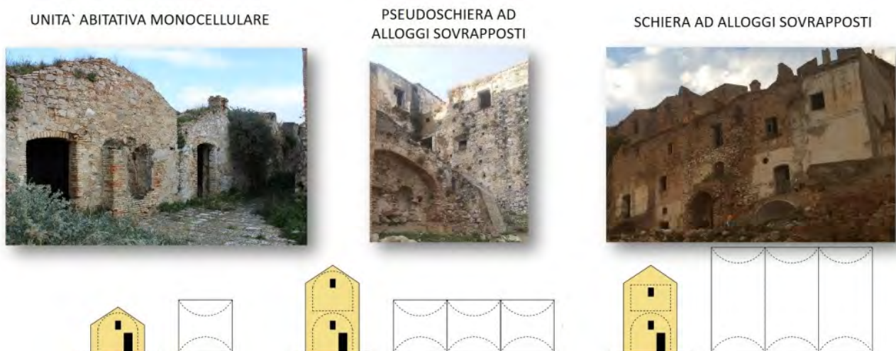
Fig. 3 – Tipologie edilizie presenti nel borgo di Craco (MT)
