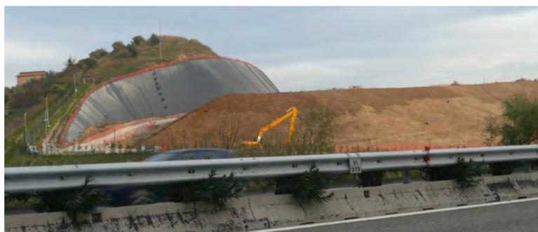
Fig. 10 – Un costone di una cava esaurita adibita a discarica a Foggia in Puglia, impermeabilizzato per evitare infiltrazioni di percolato nel sottosuolo – Fonte: foto di Catello Grimaldi
