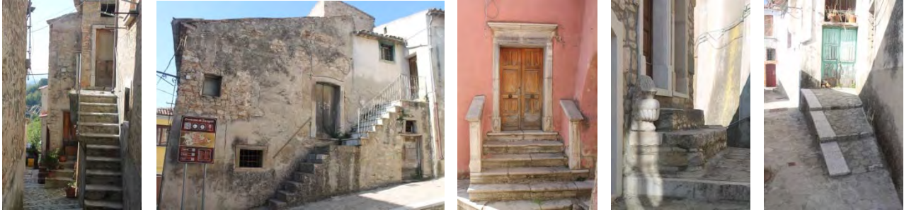
Fig. 10-11-12-13-14 – Accessi alle abitazioni: scale, pianerottoli, rampe e gradonate
