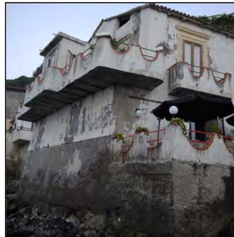
Fig. 13 – Facciate nord e ovest – Fonte: foto degli autori
