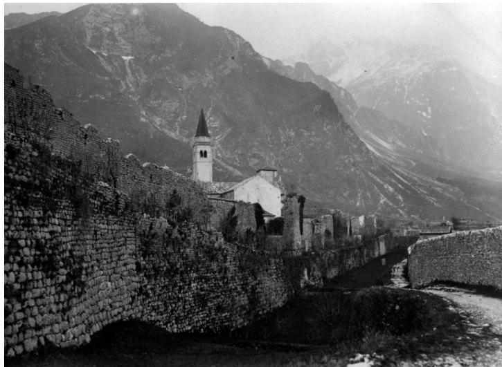
Fig. 3 – Mura di Venzone oggi – Fonte: foto di Brisighelli
