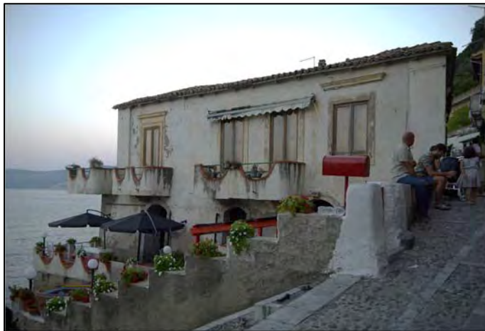
Fig. 12– Facciata ovest – Fonte: foto degli autori
