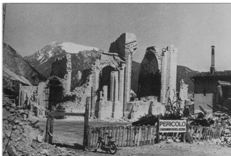
Fig. 1 – Venzone, quel che restava del Duomo dopo il sisma – Fonte: foto di Brisighelli
