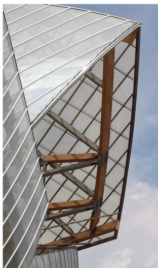
Figg. 47, 48/ Vista d'insieme e particolari della Fondazione Louis Vuitton, 2014, Parigi (Francia). Il sistema è composta da una struttura portante e da una struttura secondaria in legno lamellare e acciaio per l'ancoraggio dell'involucro. (Foto dell'autore).
