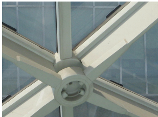
Fig. 9/ ICD/ITKE Research Pavilion ICD. Particolare del sistema di assemblaggio dei pannelli.
