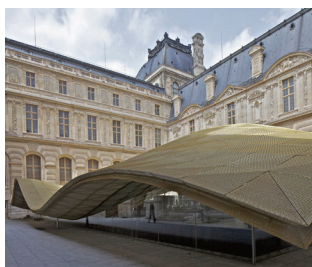
Figg. 19, 20/ Dettagli della copertura del Dipartimento delle Arti Islamiche inserita all'interno del Museo del Louvre, 2012, Parigi, progettata da M. Bellini e R. Ricciotti. esempio di sistema di post-razionalizzazione. (Foto dell'autore).
