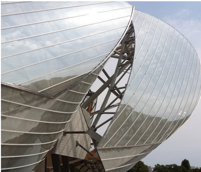
Figg. 49-51/ Particolari della Fondazione Louis Vuitton , 2014, Parigi (Francia). L'involucro è composto da strisce a singola curvatura in vetro. (Foto dell'autore).
