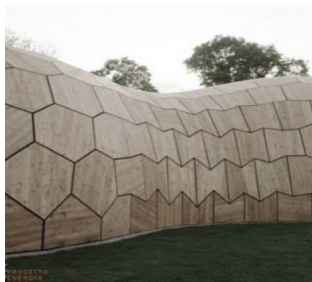
Fig. 29/ A pagina precedente: applicazione del metodo TPI sulla triangolazione di una superficie a curvatura gaussiana positiva: l'esagono risultante è piano e convesso. (Rielaborazione dell'autore).
