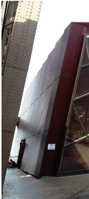
Fig. 24/ Viste di insieme e di dettaglio del Padiglione Eiffel e della cabina dell'ascensore, le cui facciate in vetro sono strisce sviluppabili. (Foto dell'autore).
