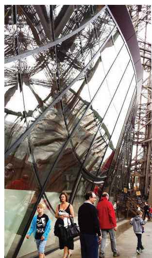
Figg. 4, 5/ Viste interna ed esterna della facciata del Padiglione Eiffel con andamento ascendente del padiglione Eiffel. (Foto dell'autore).
