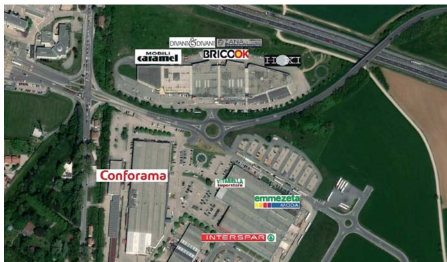
Fig. 8 - La veduta dall'alto di due complessi commerciali (il “Conforama – ex Emmezeta” e l’“Ex PRPC Merlana” sorti nel Comune di Bagnaria Arsa grazie alla presenza di grandi strutture specializzate singole
